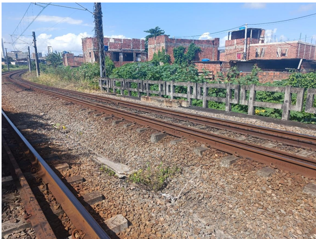
Foto 2-23 – Lastro escorre pelas juntas de dilatação do elevado (local do descarrilhamento em Novembro/2020), caindo sobre veículos e pedestres - Linha Sul Elétrica
