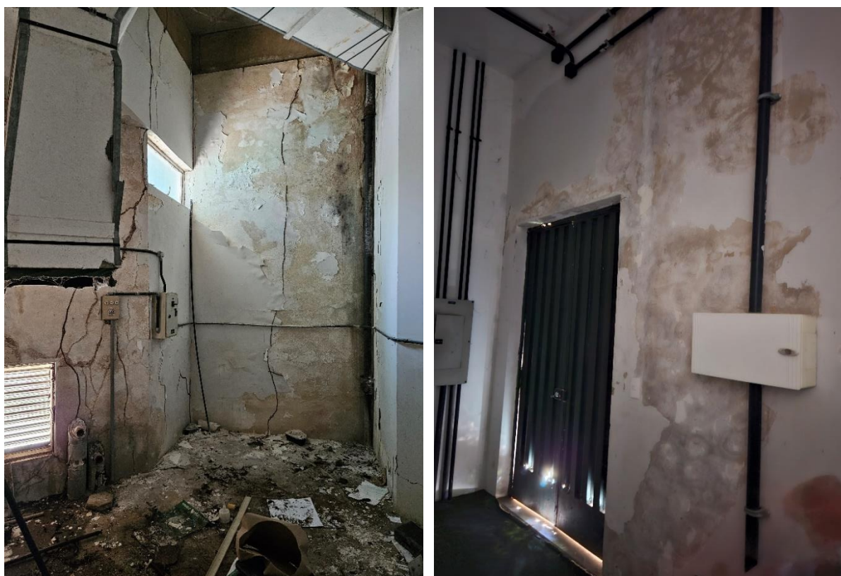
Foto 11-17: Prédio Auditorio – áreas internas com rachaduras, infiltrações, fiações expostas
