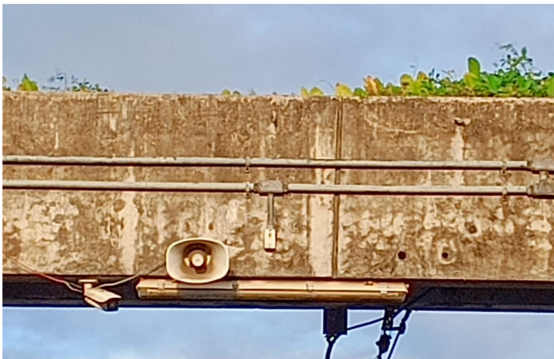
Foto 9-36: Câmera digital exposta a intempéries devido à queda de telhado – Estação Joana Bezerra
