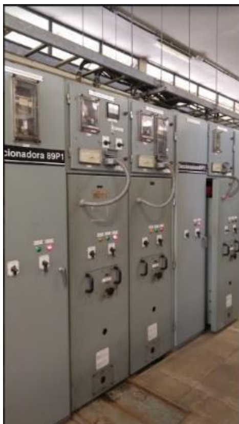
Foto 7-26: Painel de 3 kV CC
