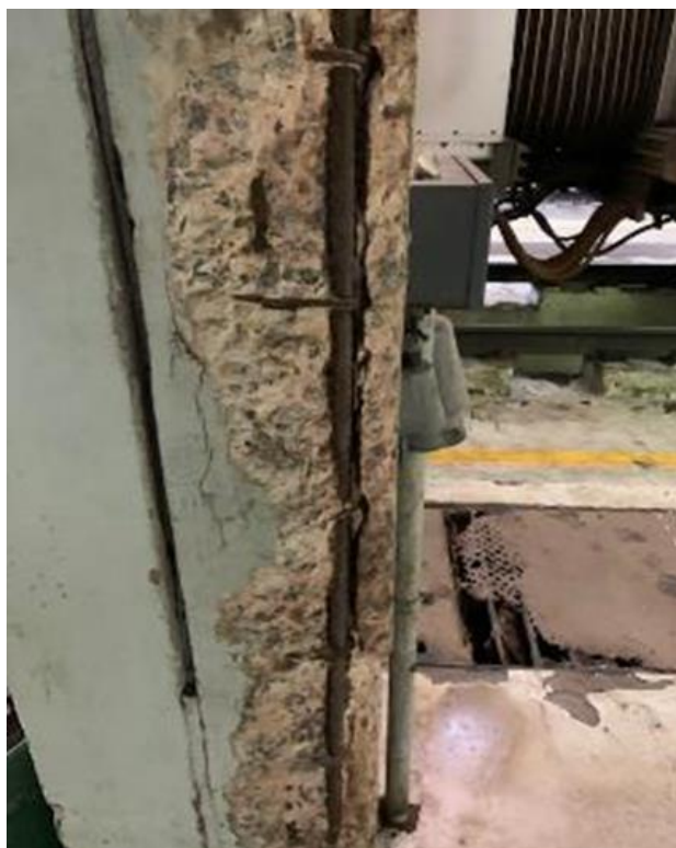
Foto 12-39: Ferragem exposta e oxidada em pilar do Bloco 4
