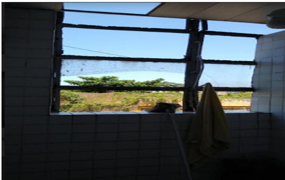
Foto 12-70: Janelas com estrutura completamente oxidada, não permitindo a fixação dos vidros
