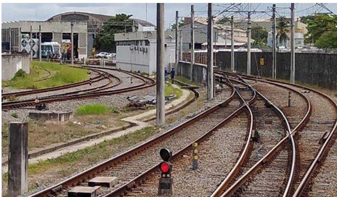
Foto 12-84: Pátio de Cajueiro Seco. Em primeiro plano as Linhas em bitola larga. À esquerda as Linhas de bitola métrica. O Posto de Movimento de Trens entremeando os dois conjuntos de Linhas e ao fundo a Base de Manutenção com um VLT estacionado na Linha com fosso.
