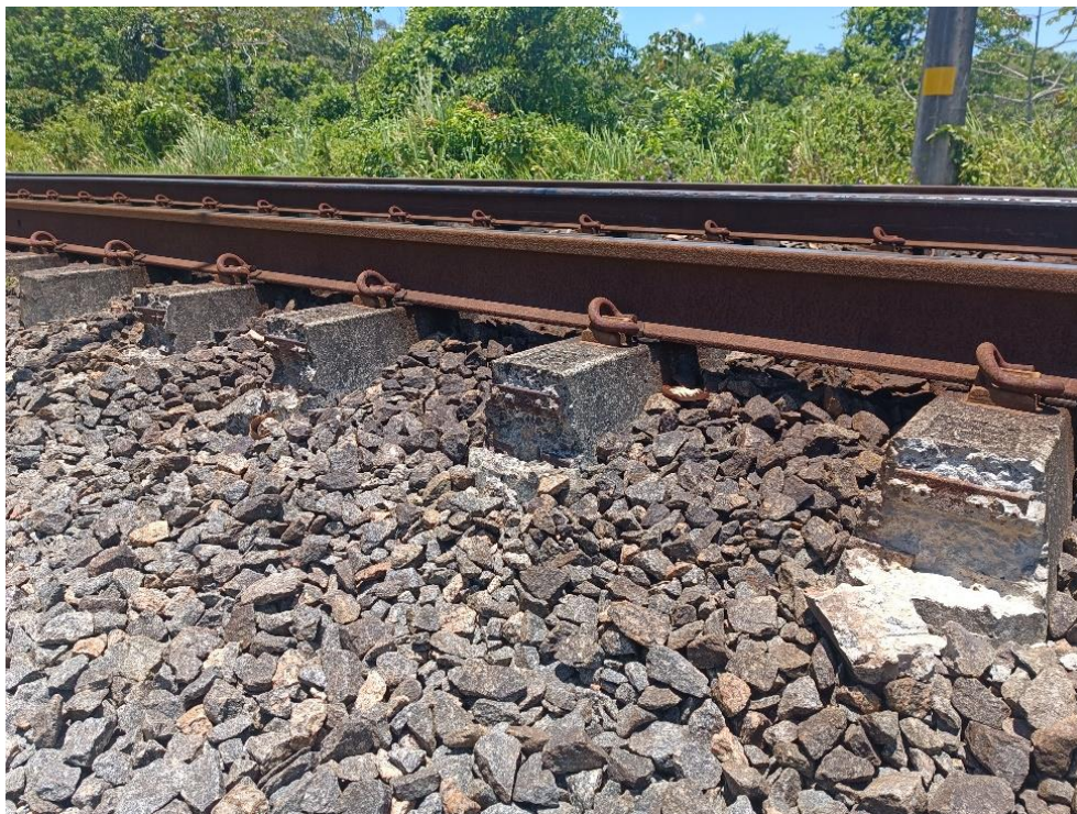
Foto 2-14: Dormentes danificados por ação da Reação Álcali Agregado (RAA) – Linha Sul Elétrica e Linha Centro na Ligação entre a Estação Rodoviária e Camaragibe.
