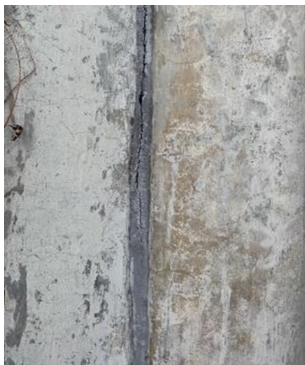
Foto 12-38: Junta de Dilatação ressecada e fissurada
