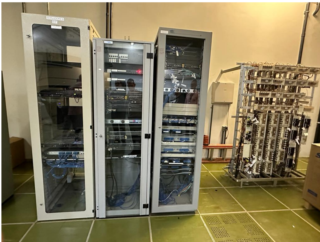
Foto 11-45: Bastidores do STO e DG de Telefonia: Sala de Telecom do CCO
