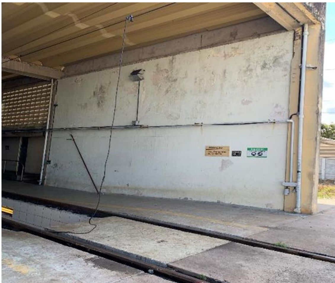
Foto 12-11: Paredes com infiltrações
