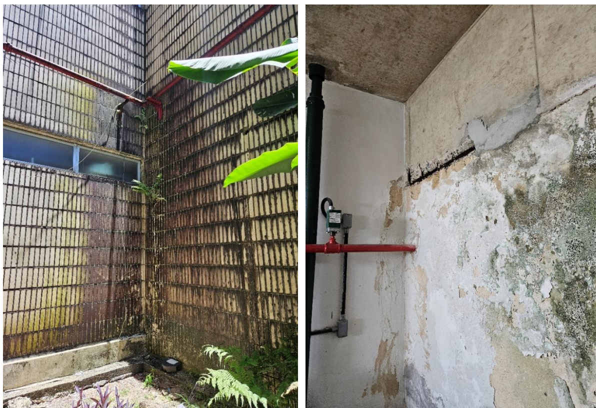
Foto 11-23: Prédio Administrativo – Ferragens expostas e infiltrações externamente e internamente
