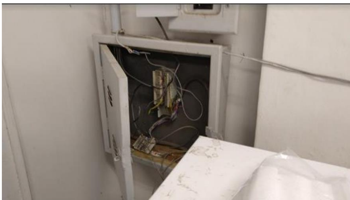
Foto 12-71: Instalações telefônicas precárias e fora de norma
