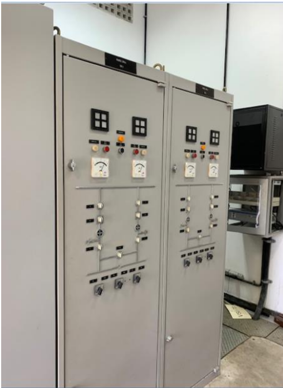
Foto 7-28: Painel de comando do 3 kV CC
