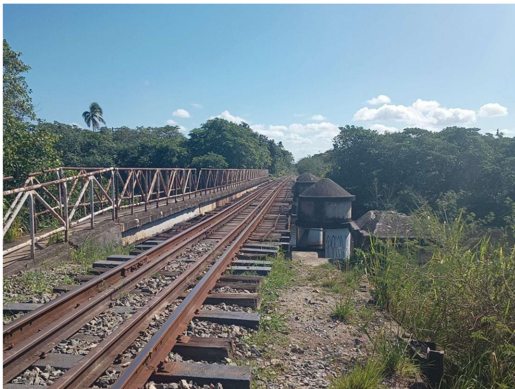
Foto 3-2: Ponte sobre o Rio Jaboatão (ID 9, Tabela 3-1) - Linha Sul Diesel. Encontro com escoramento
