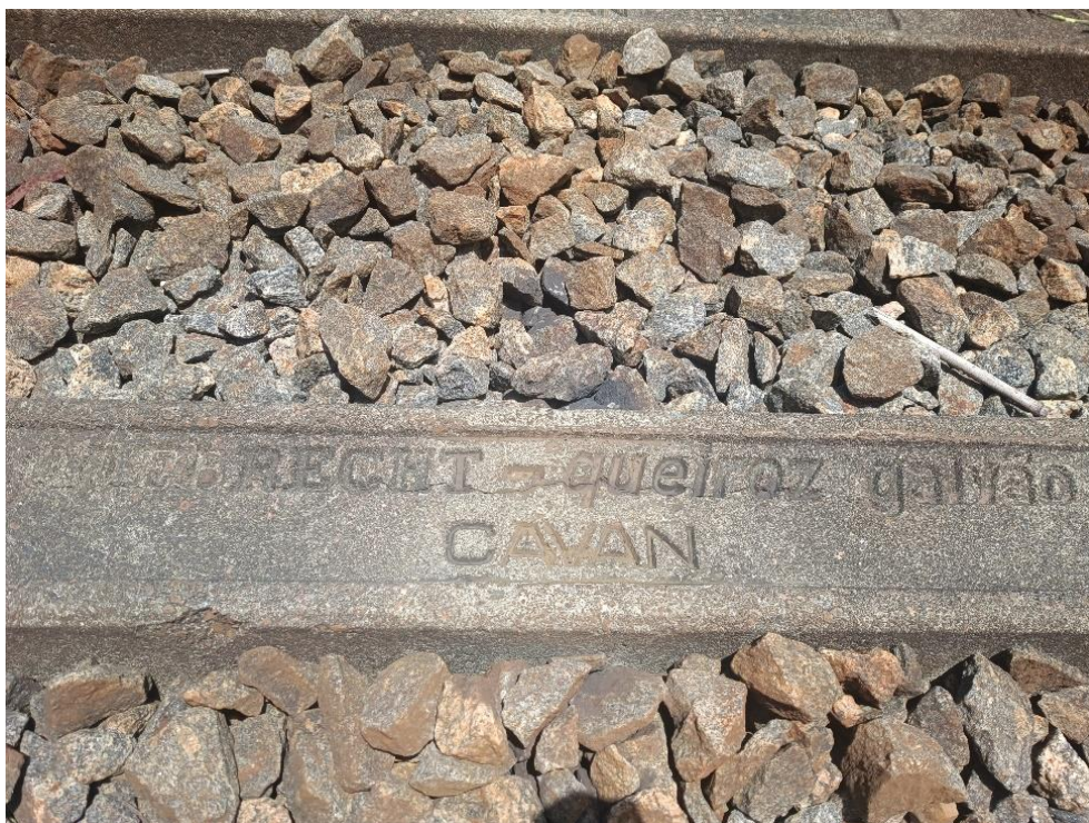
Foto 2-13: Dormente de concreto fissurado por ação da Reação Álcali Agregado (RAA) – Linha Sul Elétrica e Linha Centro na Ligação entre a Estação Rodoviária e Camaragibe.
