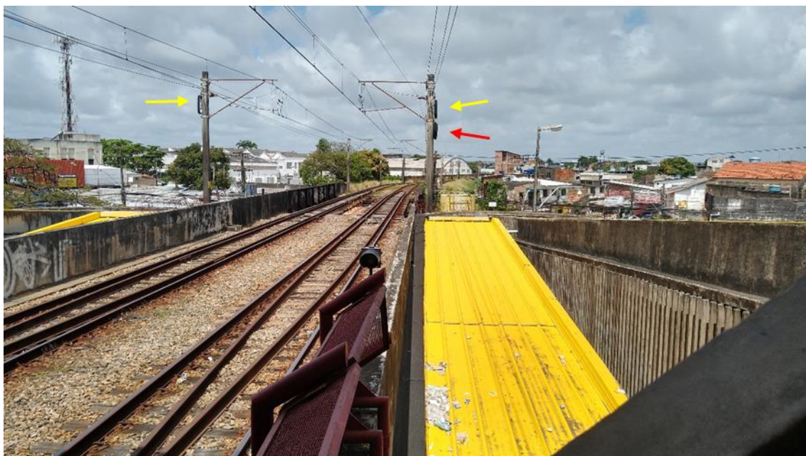
Foto 9-5: Reservas técnicas de cabo óptico em postes da Rede Aérea, a Oeste da Estação Afogados (duas reservas do cabo óptico do STO e uma reserva do cabo óptico Telebras)
