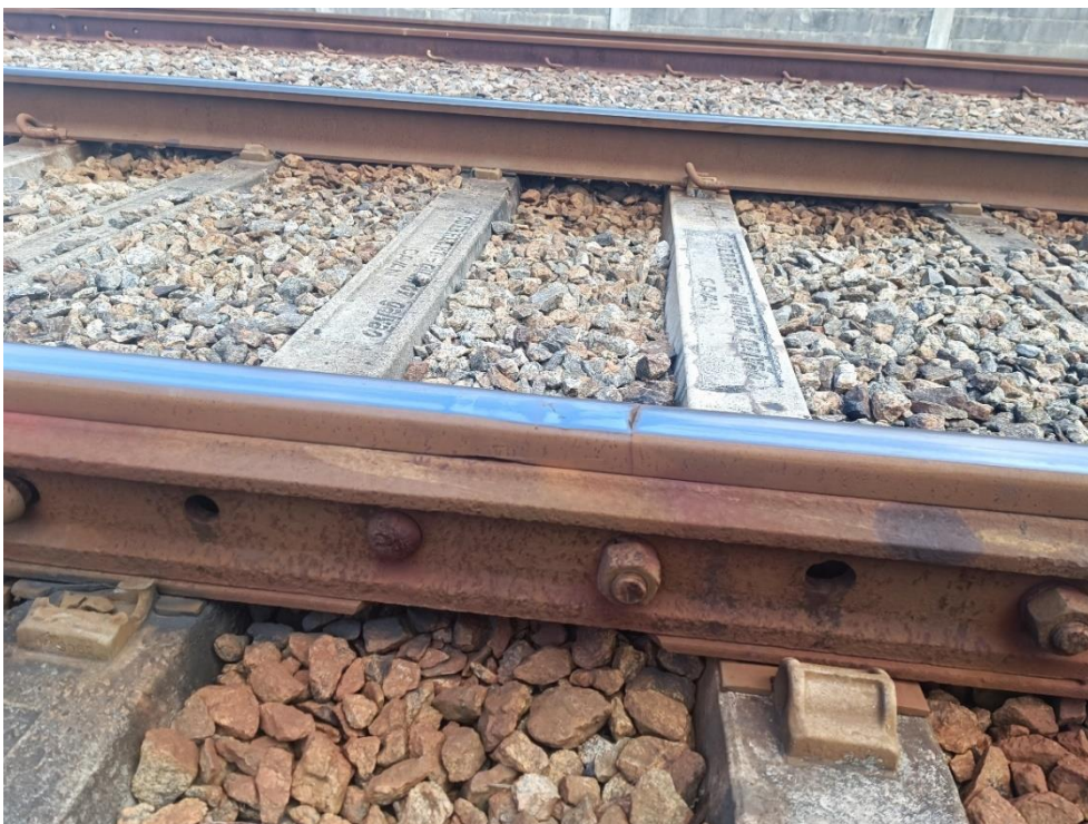
Foto 2-21: Trilho partido unido por junta mecânica (nota-se o boleto e patim quebrados), olhal quebrado e falta de fixação – Linha Sul Elétrica.
