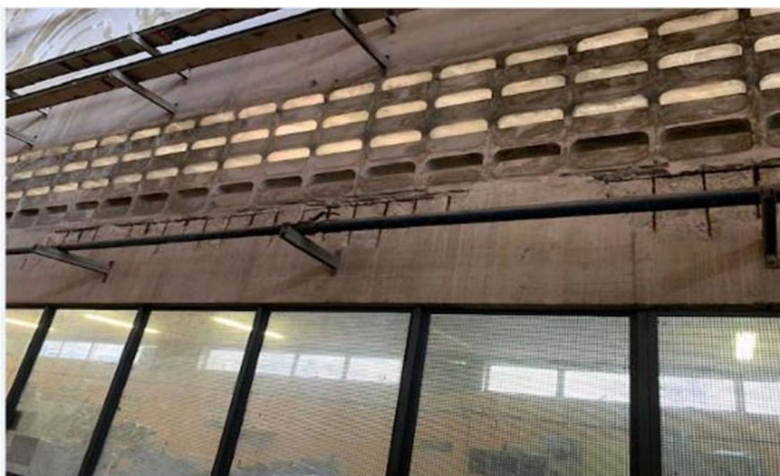
Foto 12-42: Viga no Bloco 4 com ferragem oxidada
