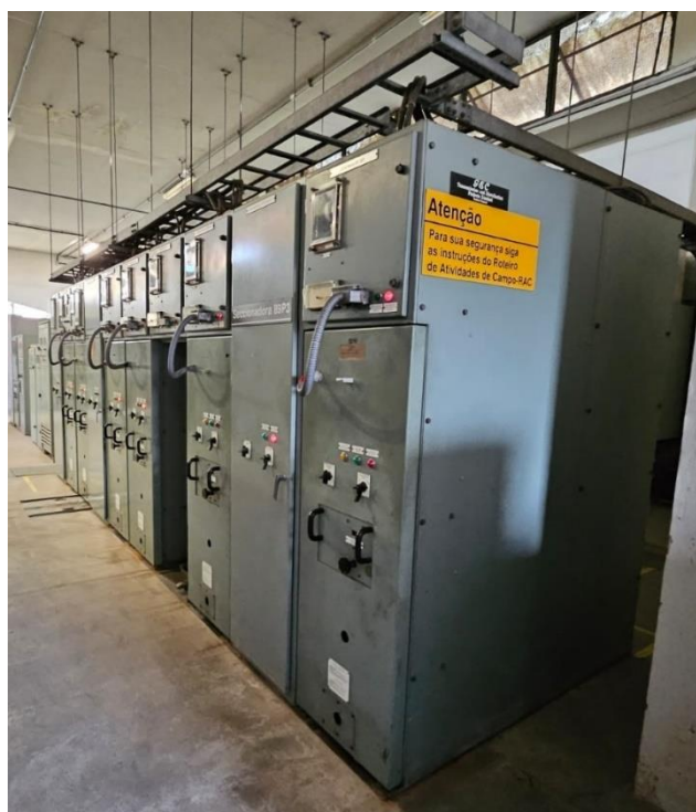
Foto 7-23: Seccionadoras da SE Coqueiral
