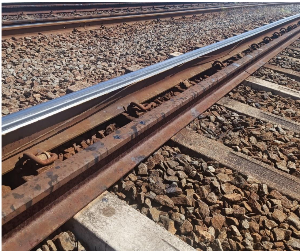
Foto 2-18: Trilho com desgaste acentuado e perda de material – Linha Sul Elétrica
