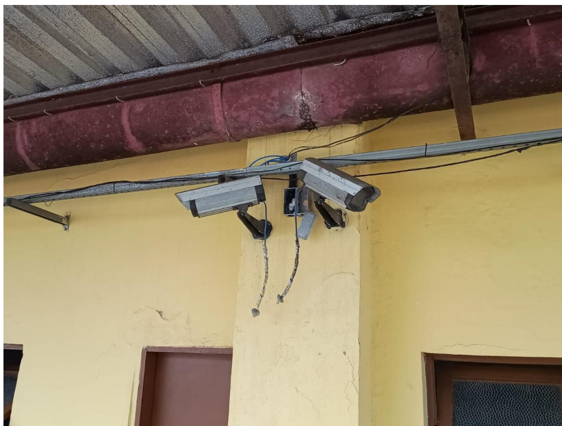
Foto 9-33: Câmeras analógicas inoperantes na plataforma da Estação Cabo – Linha Sul Diesel
