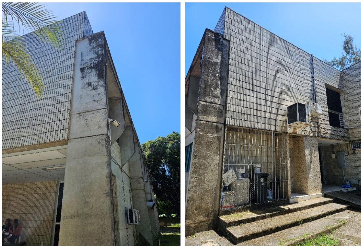
Foto 11-11: Vista Externa Prédio RH – Infiltrações
