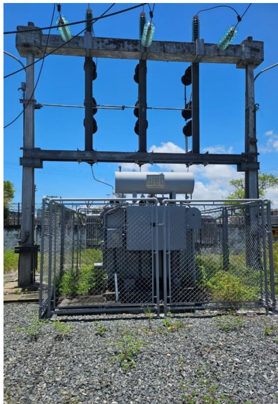
Foto 7-6: Transformador 500kVA – 69-13,8kV para as SSA's
