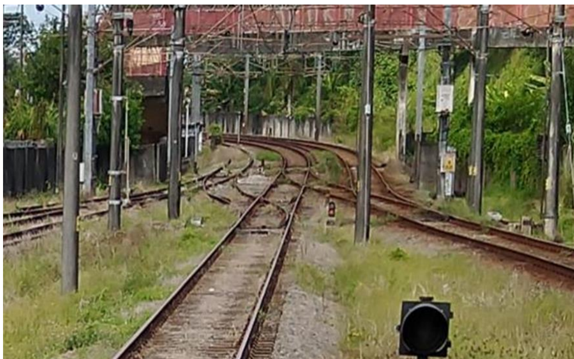
Foto 12-122: Via auxiliar de Jaboatão. Detalhes: Ao fundo, da esquerda para a direita: A linha de manobra para entrada no Pátio. A via 1 e a Via 2. Travessões de manobras
