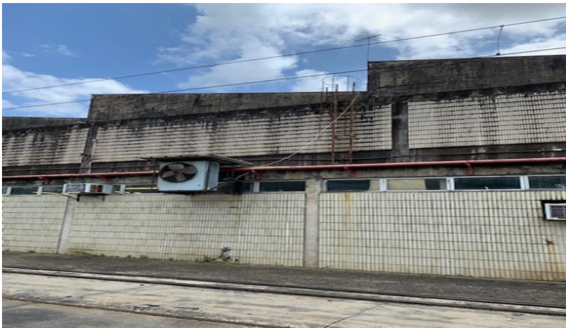
Foto 12-41: Fachada do Bloco 4 precisando de lavagem e impermeabilização
