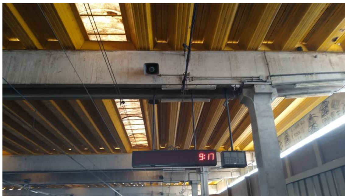
Foto 9-12: Corneta de Sonorização, Painel de Informação e Painel IDT (Indicador de Destino de Trem) – Plataforma da Estação Joana Bezerra
