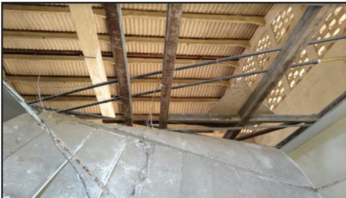
Foto 12-72: Forro de uma das salas do escritório (desabou). Forros das demais salas em situação de risco de desmoronamento
