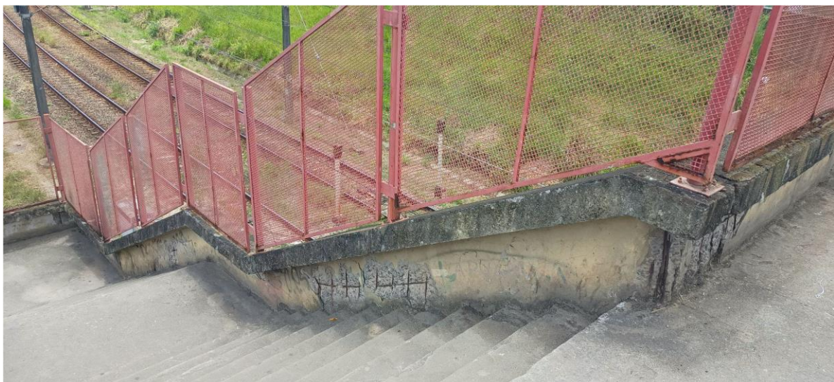
Foto 3-20: Ferragens expostas – Passarela de Pedestres de Coqueiral - Linha Centro Elétrica (ID 19, Tabela 3-3)
