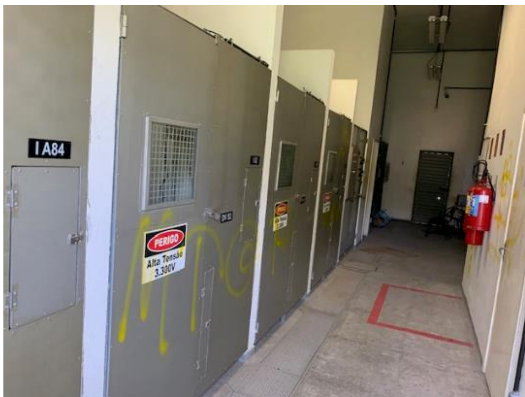
Foto 7-36: Celas dos disjuntores de 3 kV CC pichadas
