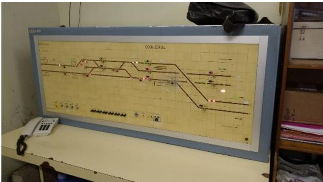
Foto 8-9: Linha Centro – SCO Estação Coqueiral: IHM de Sinalização GEC
