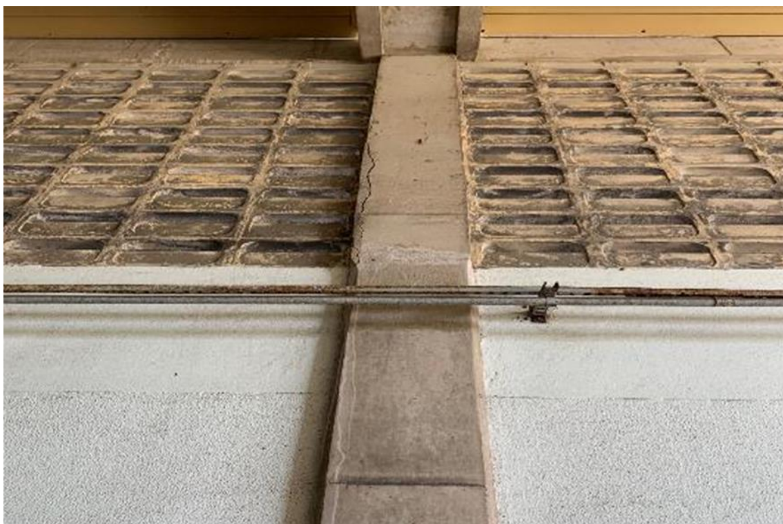
Foto 12-10: Pilares apresentando fissuras (estrutura da OPR)
