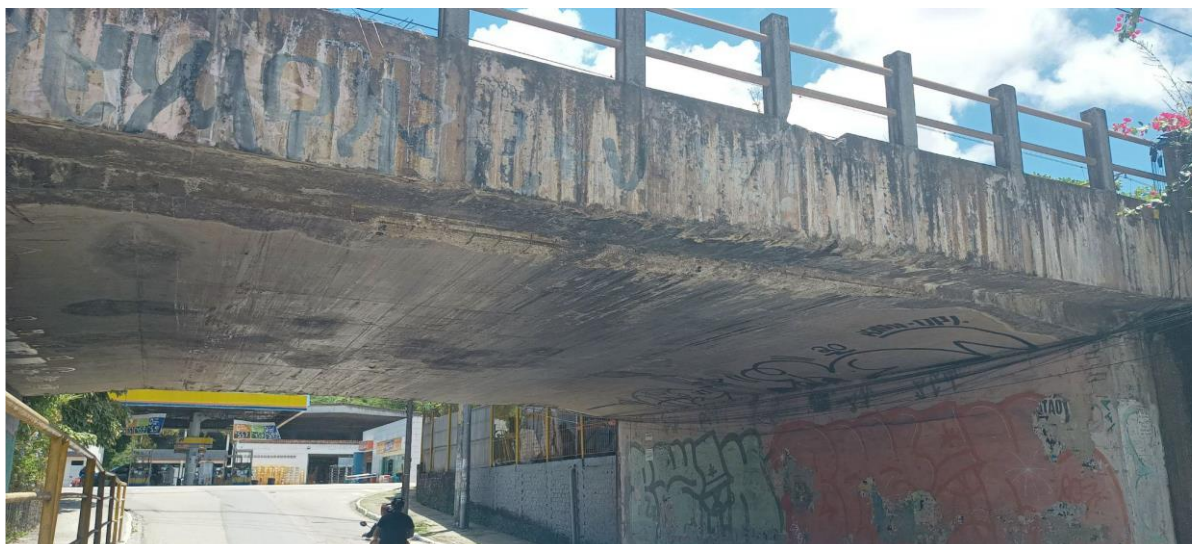
Foto 3-8: Ferragens Expostas – Viaduto Ferroviário do Sancho (ID 8, Tabela 3-2) - Linha Centro Elétrica
