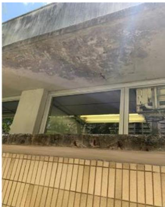
Foto 12-45: Ferragem oxidada em laje do Bloco 5 – Laboratório de Eletrônica
