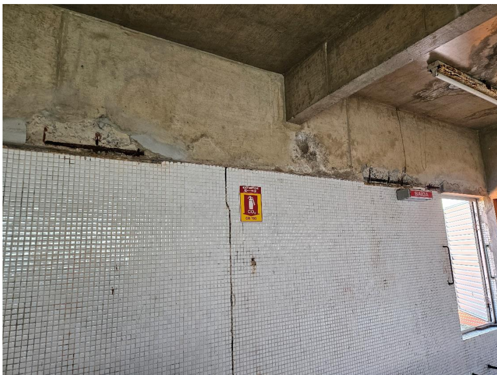
Foto 11-24: Prédio Administrativo – Ferragens expostas e infiltrações externamente e internamente
