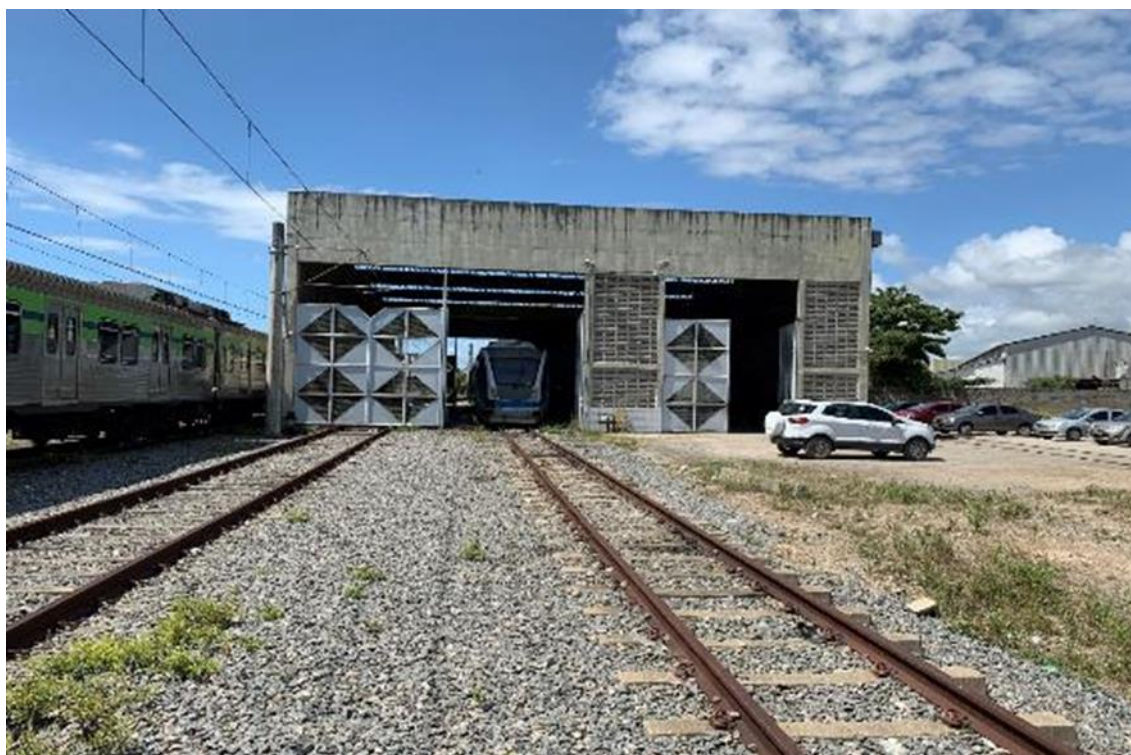
Foto 12-86: Pátio de Cajueiro Seco e Base de manutenção. Da esquerda para a direita: TUE estacionado na Linha de guarda de trens, Linha em bitola larga com fosso de inspeção, vazia e VLT estacionado na Linha de bitola métrica com fosso de inspeção
