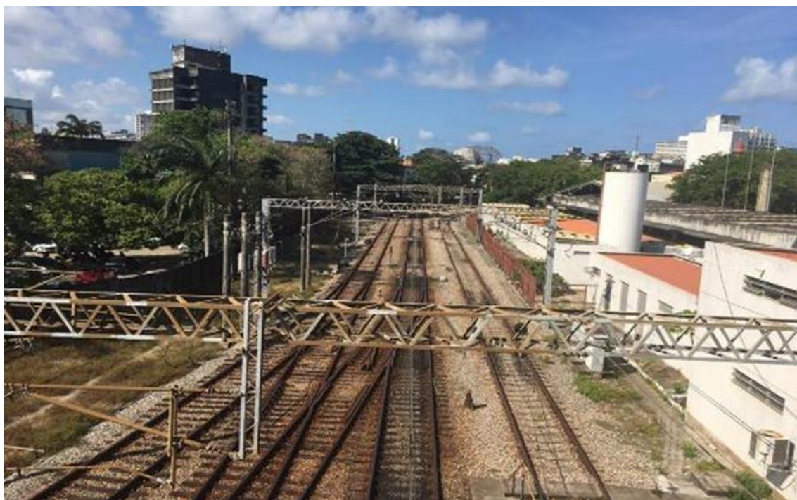
Foto 12-3: Da esquerda para a direita: Linha de Manobra, para acesso à OPR e Linha de Guarda
