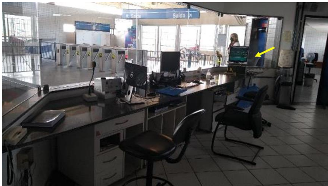
Foto 8-19: Linha Sul Elétrica – SCO da Estação Tancredo Neves: Console de Sinalização Alstom
