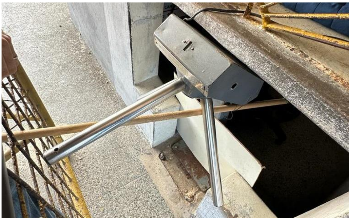
Foto 10-10: Cabo de vassoura sendo utilizado para liberação manual do tripé de acesso – Estação Pontezinha
