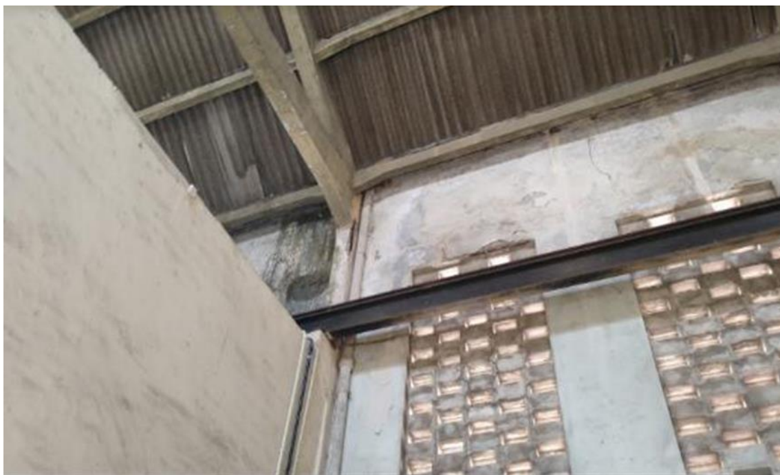
Foto 12-64: Sinais de Infiltração e Necessidade de Recuperação Estrutural
