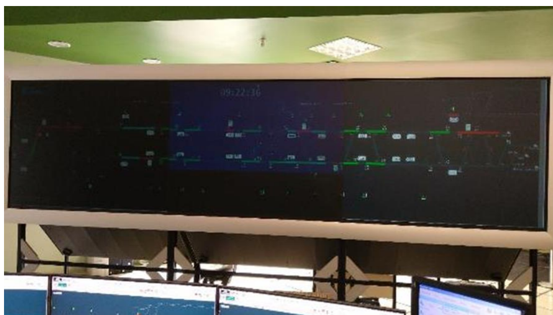
Foto 8-22: Painel no CCO – Sinótico Sinalização Linha Sul Elétrica
