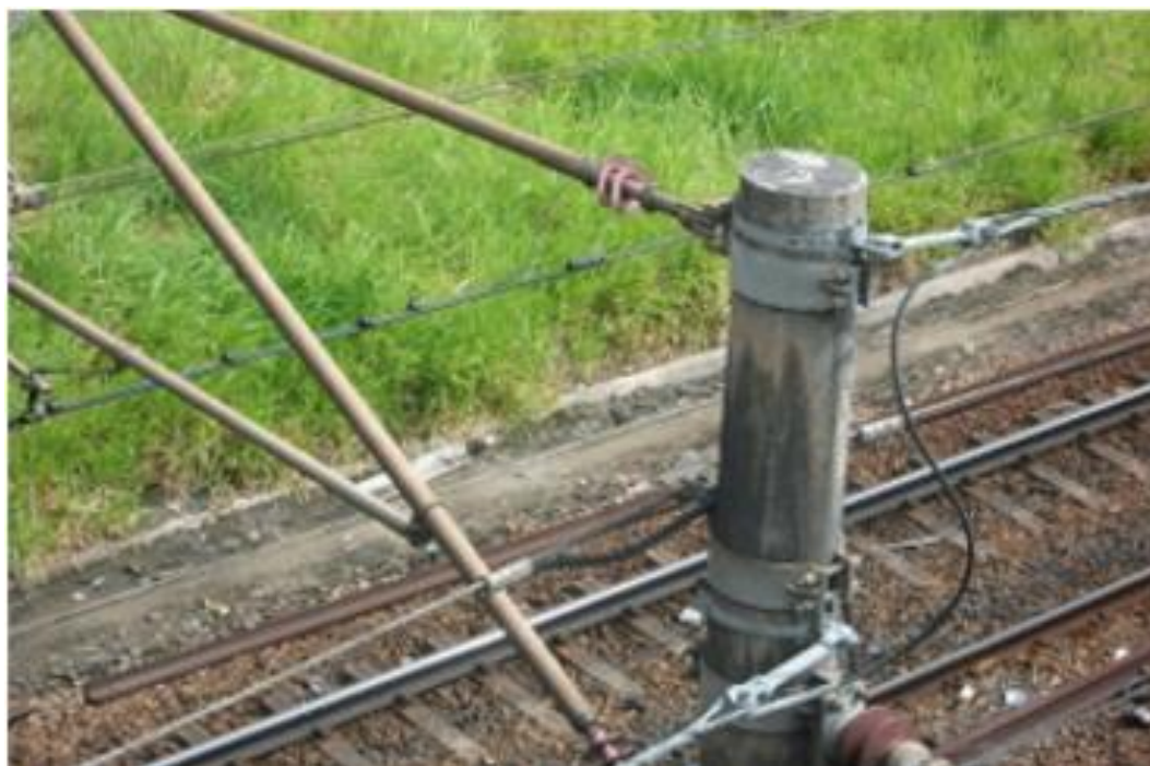
Foto 7-42: Cabo de falta aéreo – AFW
