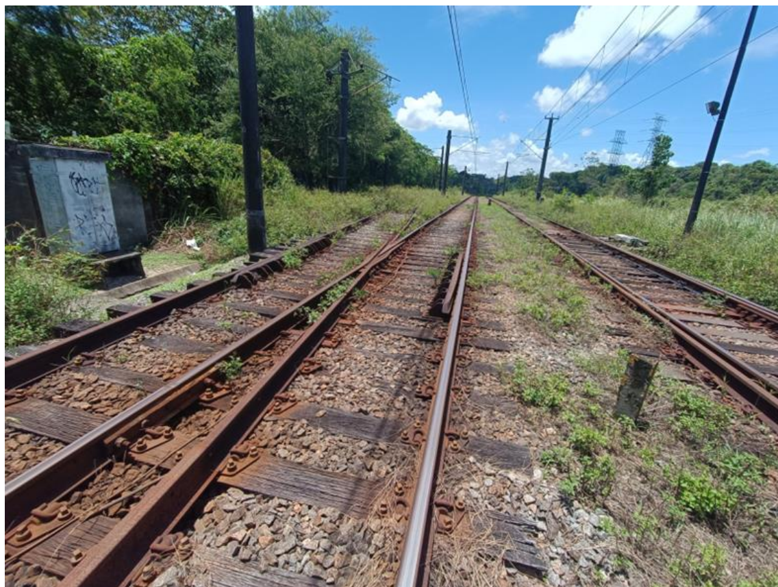
Foto 12-126: À esquerda, entrada para a via auxiliar da Rodoviária, com duas linhas de guarda de trens.
