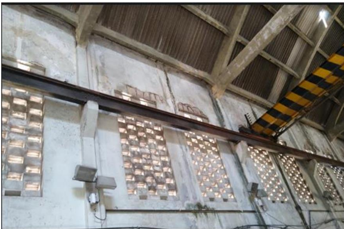
Foto 12-65: Cobertura Danificada e Ferragem Exposta de Vigas
