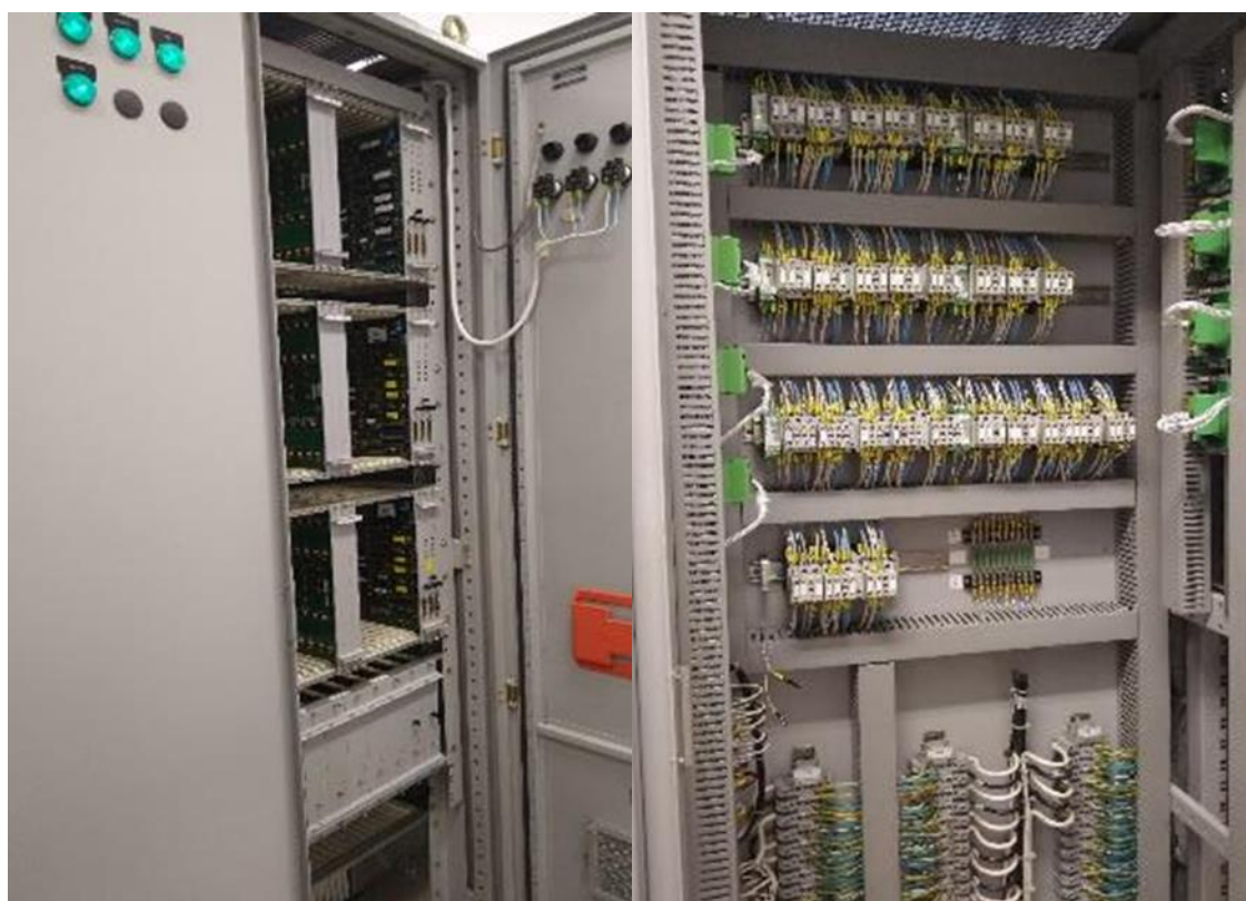
Foto 8-18: Linha Sul Elétrica – Sala de Telecom da Estação Tancredo Neves: Bastidores Sinalização Alstom
