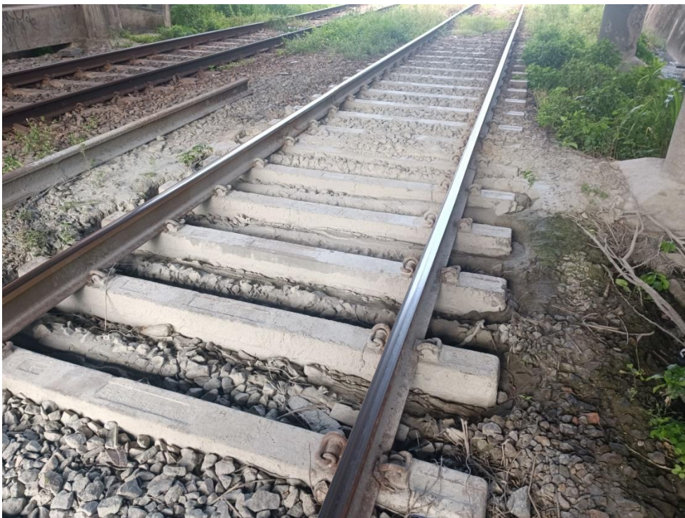
Foto 2-20: Colmatação severa do lastro (presença acentuada de material pulverulento no lastro) – Linha Sul Elétrica.
