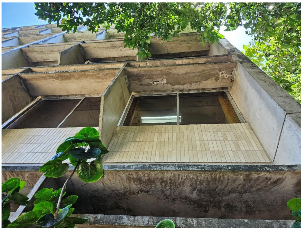
Foto 11-22: Prédio Administrativo – Ferragens expostas e infiltrações nos elementos de concreto da fachada
