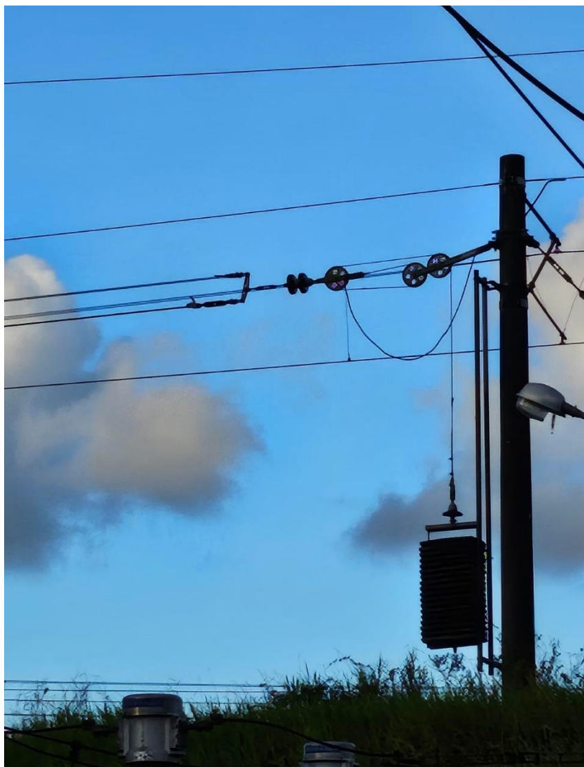
Foto 7-51: Sistema de Compensação da Rede Aérea
