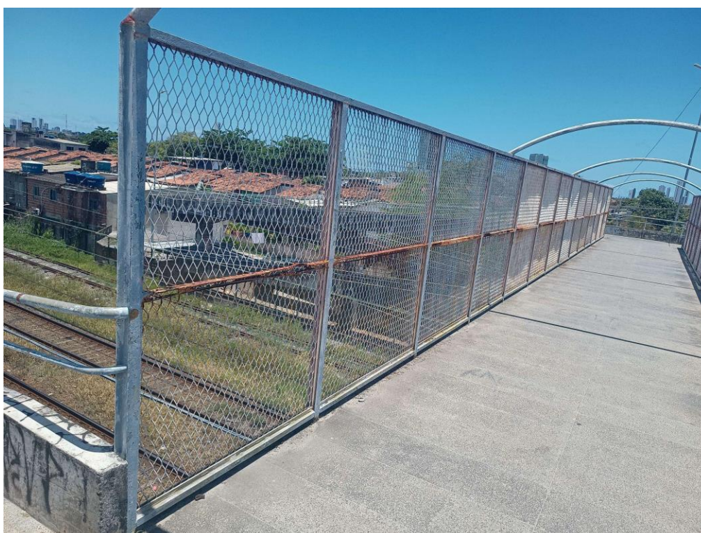
Foto 3-18: Grades de proteção da Passarela de Pedestres da Rua Manoel Serafim do Couto bastante oxidadas - Linha Sul Elétrica (ID 30, Tabela 3-3)
