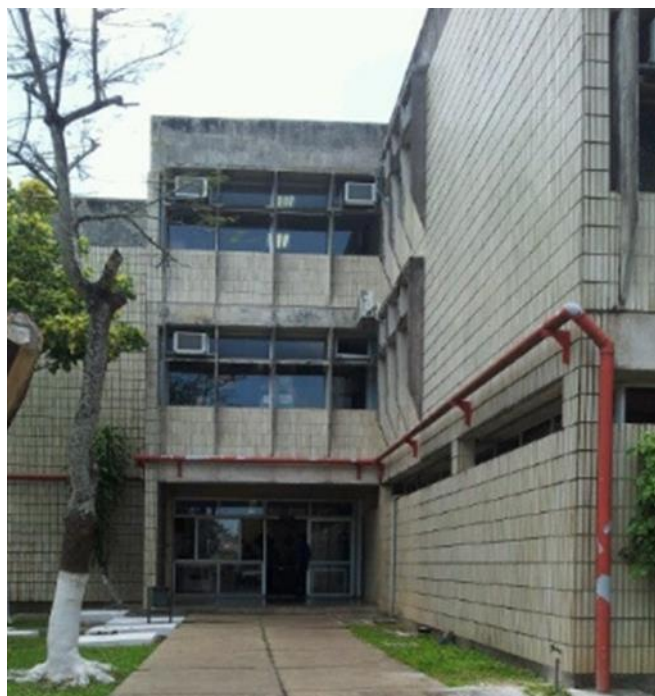
Foto 12-32: Fachada do Bloco 1, precisando de lavagem e impermeabilização
