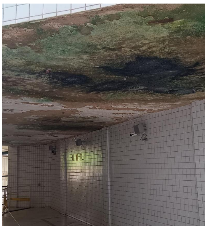
Foto 9-55: Equipamentos de sonorização e CFTV sofrendo infiltrações
