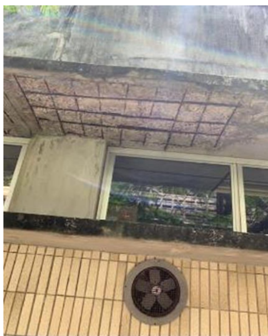
Foto 12-44: Ferragem exposta e oxidada em marquise do Bloco 5 – Laboratório de Eletrônica
