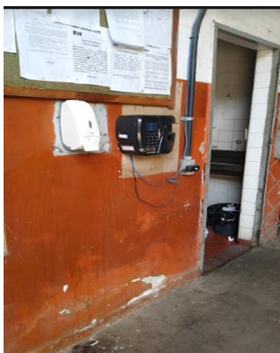
Foto 12-67: Instalações irregulares e fora de norma
