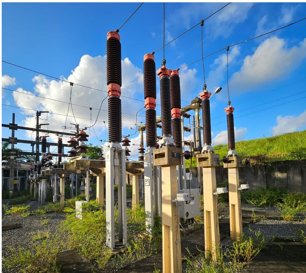
Foto 7-18: Disjuntores da SE Coqueiral
