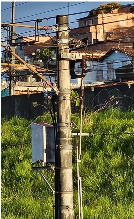
Foto 7-49: Chave seccionadora
