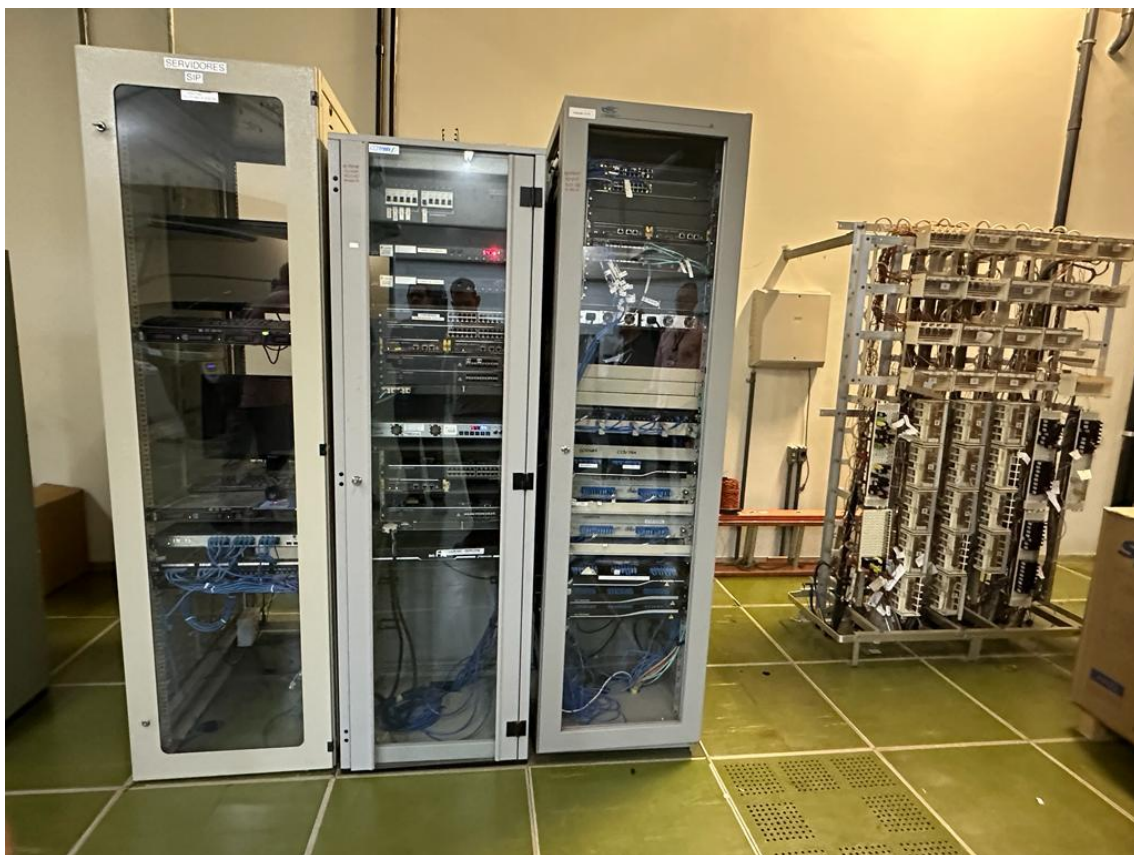
Foto 9-1: Bastidores do Sistema de Transmissão Óptico, instalados na Sala de Telecom do CCO
