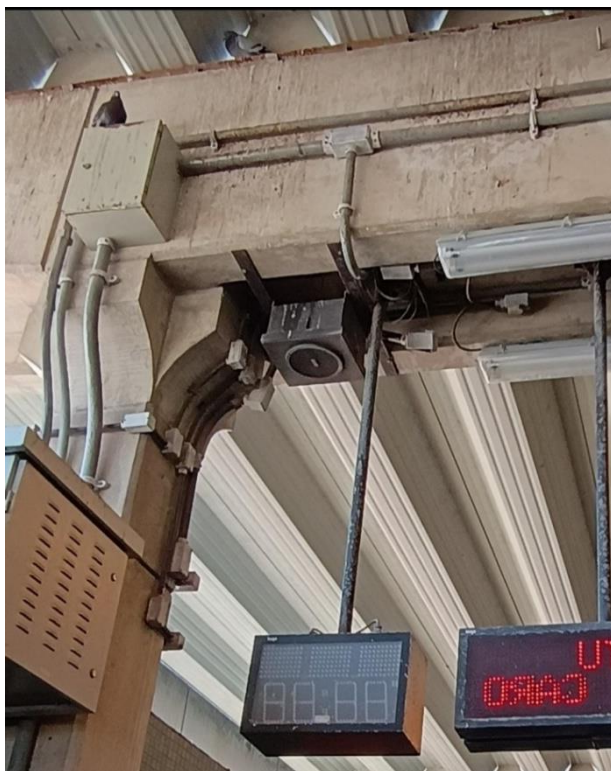
Foto 9-53: Presença de pombos ao redor dos equipamentos de telecomunicações
