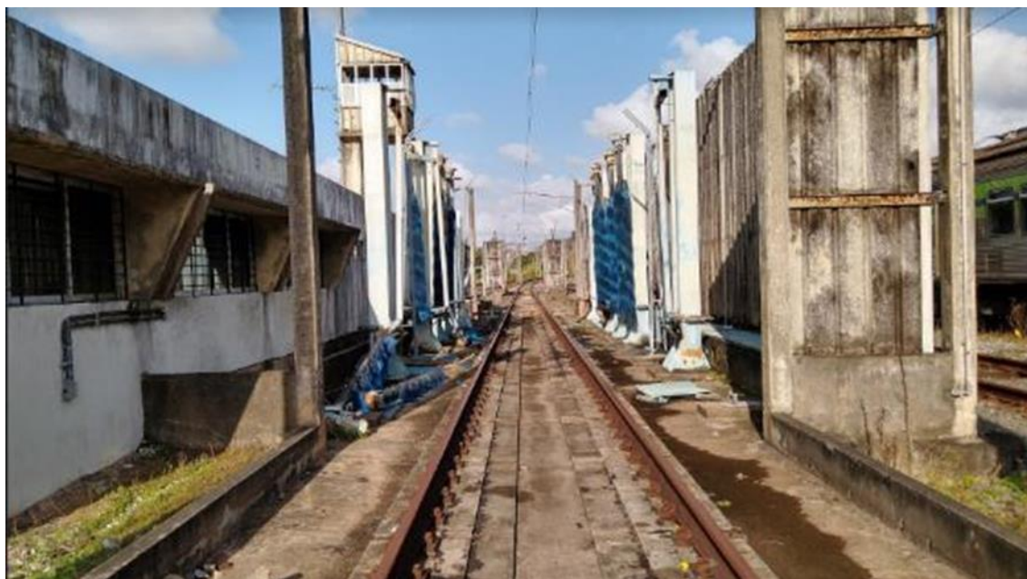
Foto 12-47: Bloco 11 – Máquina de lavar trens inoperante e parcialmente desmontada
