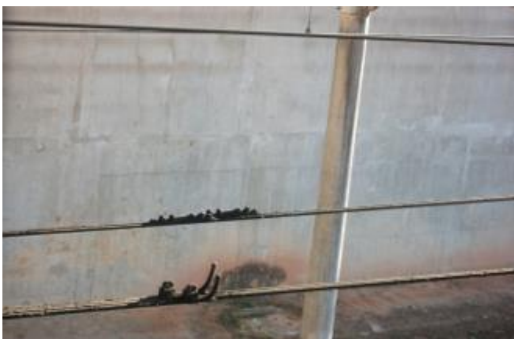
Foto 7-46: Solução provisória – paralelo no fio de contato
