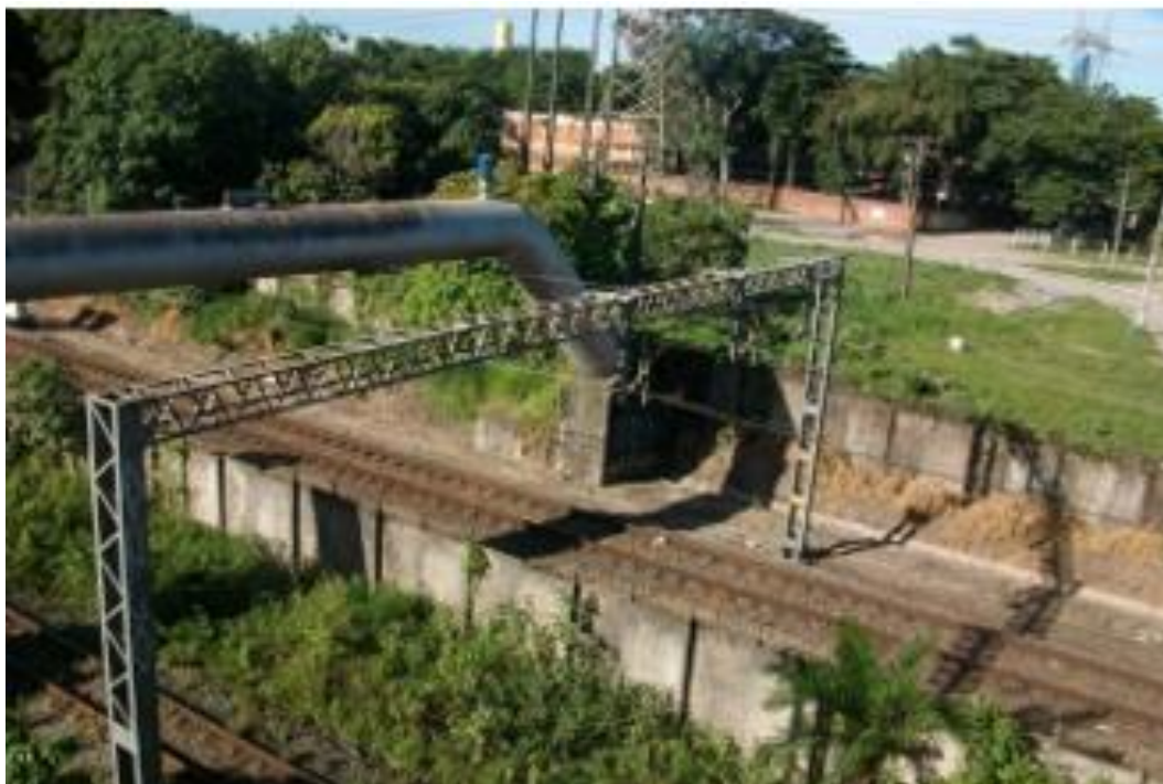
Foto 7-43: Pórtico com sinais de oxidação
