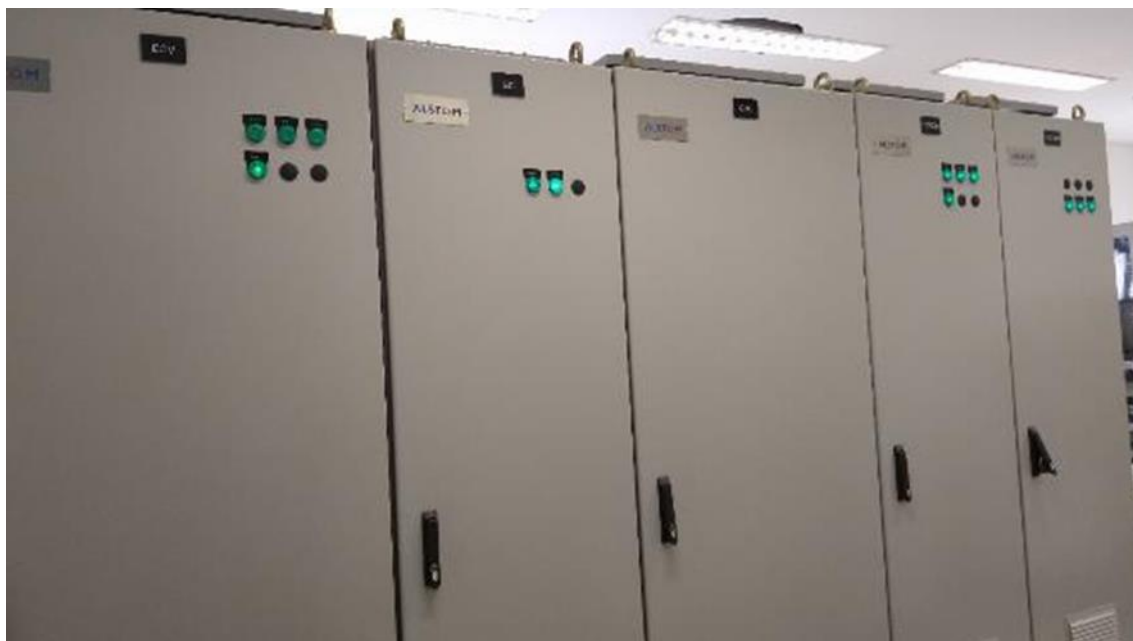
Foto 8-17: Linha Sul Elétrica – Sala de Telecom da Estação Tancredo Neves: Bastidores Sinalização Alstom
