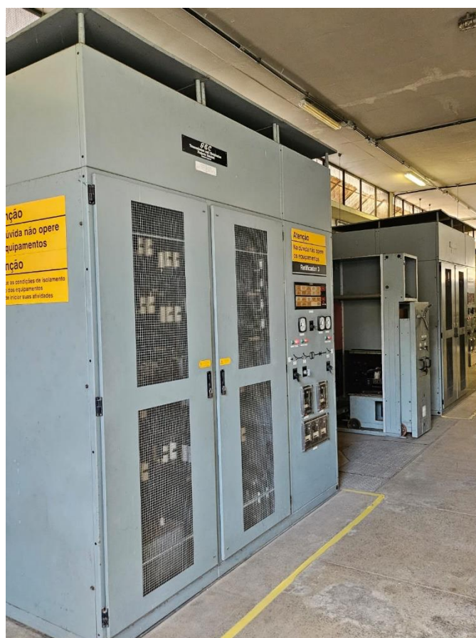
Foto 7-21: Retificador da SE Coqueiral
