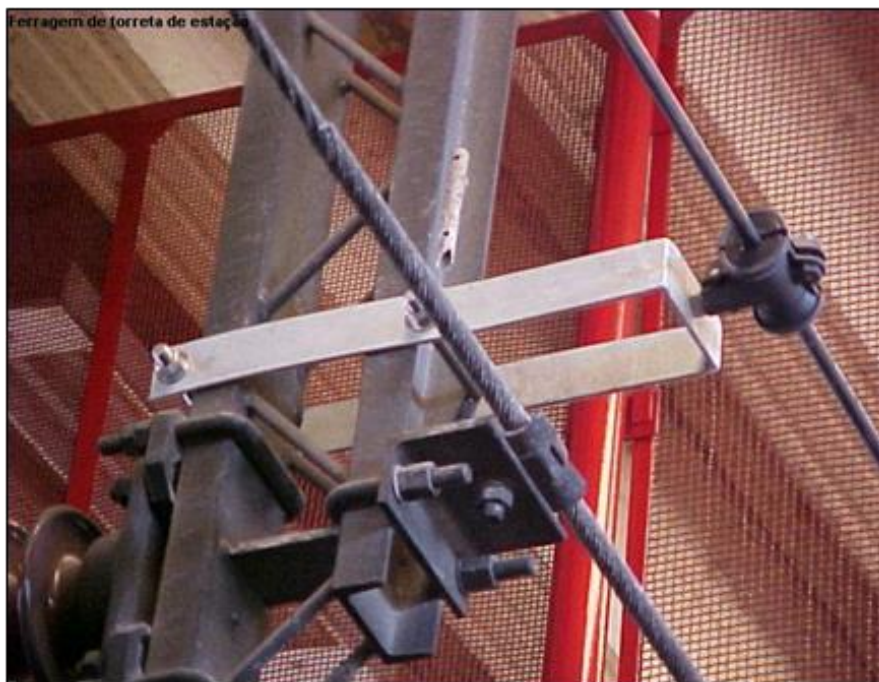
Foto 9-7: Suporte especial, fixado à estrutura metálicas de estação da Linha Sul Elétrica, para instalação de dielétrico
