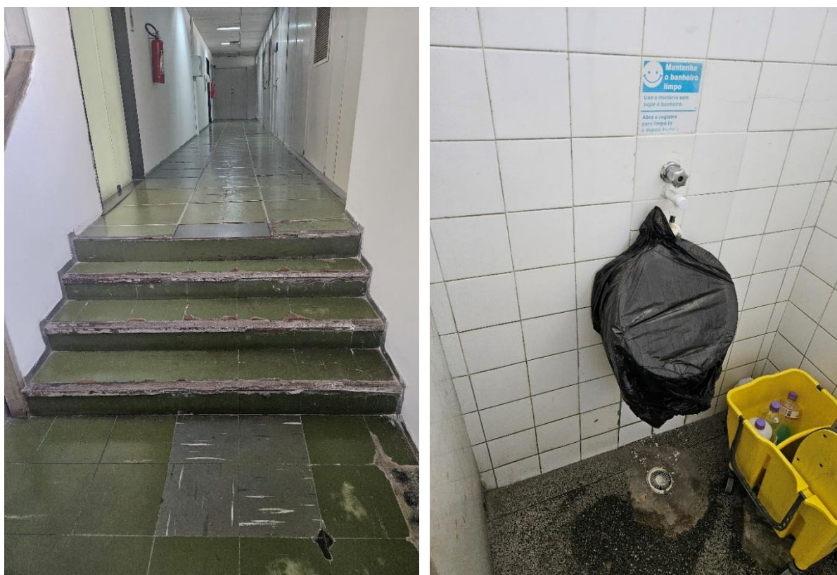
Foto 11-29: Degraus Danificados. WC's com mictórios interditados e demais elementos danificados
