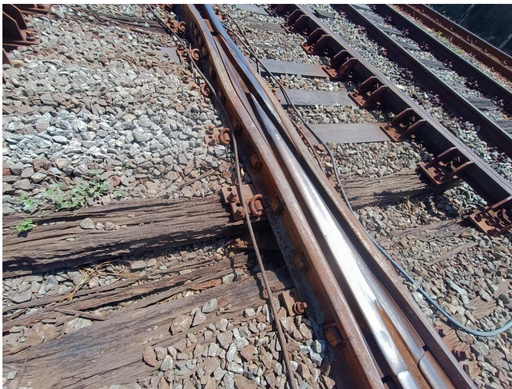
Foto 2-16: Dormentes de AMV comprometidos – Linha Sul Elétrica
