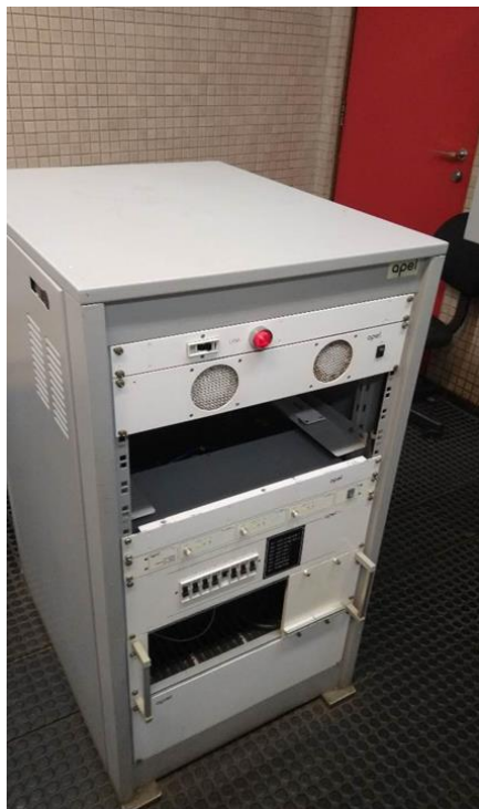
Foto 9-15: Rack de Sonorização: Estação Linha Centro
