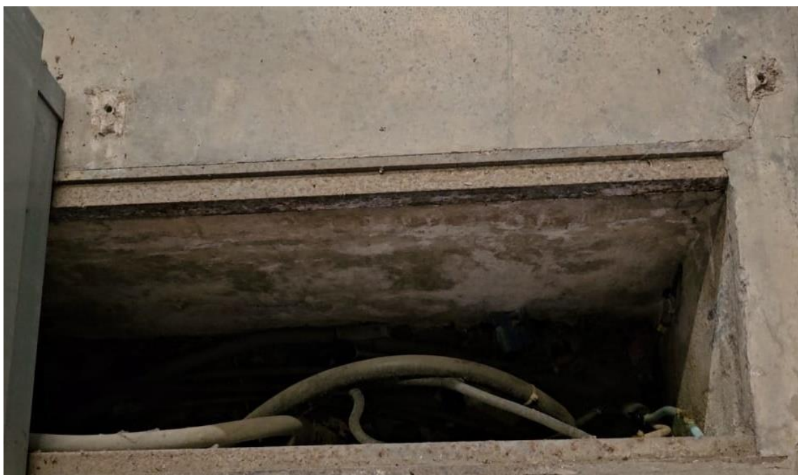
Foto 7-10: Sala técnica – falta de tampa
