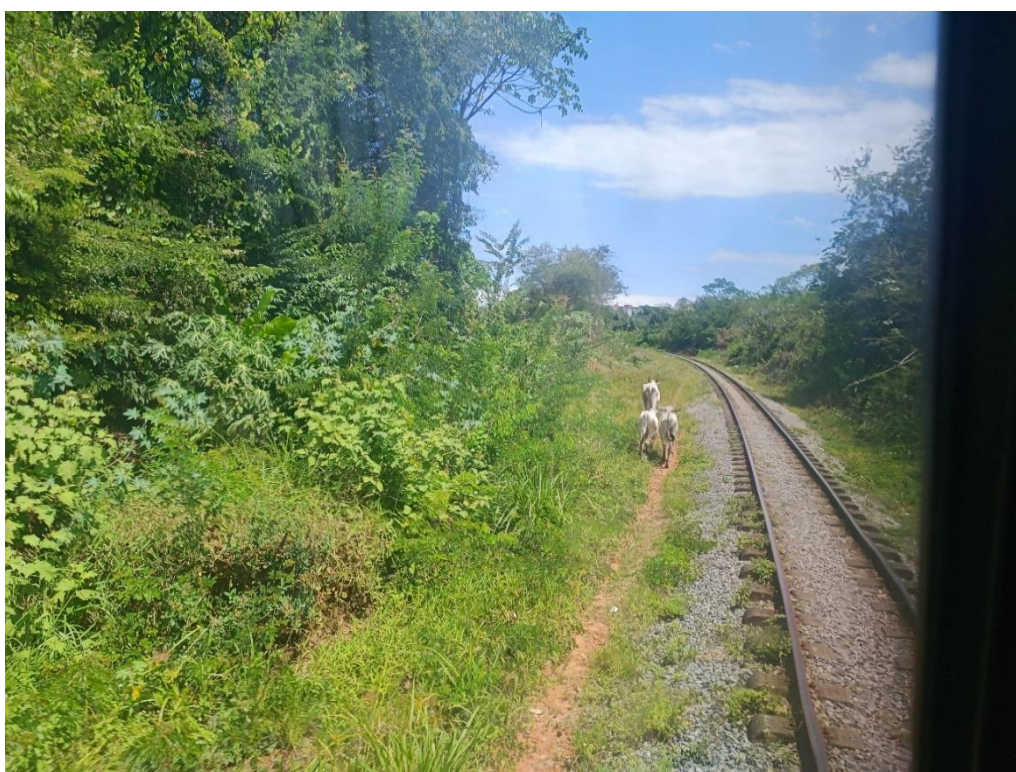
Foto 2-25: Falta de brita no ombro do lastro e presença de animais na via, aumentando risco de abalroamento – Ramal de Ligação Cajueiro Seco-Curado
