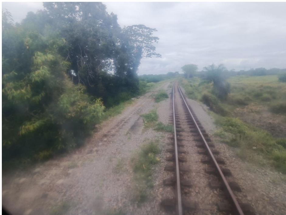
Foto 2-9: Trecho de duplicação da Linha Sul Diesel paralisado – À esquerda os dormentes que restaram da obra de duplicação, já sem os trilhos roubados.
