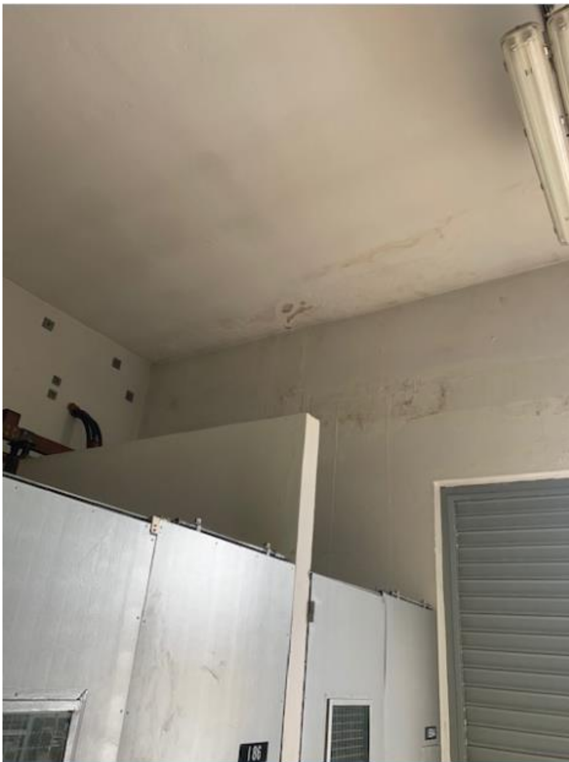
Foto 7-40: Teto da Casa de Comando com sinais de infiltração
