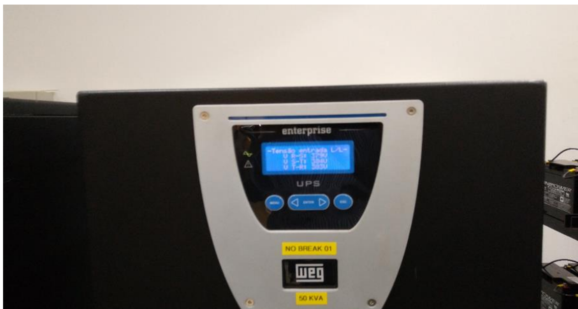
Foto 9-49: No-break: Sala de Telecom – CCO
