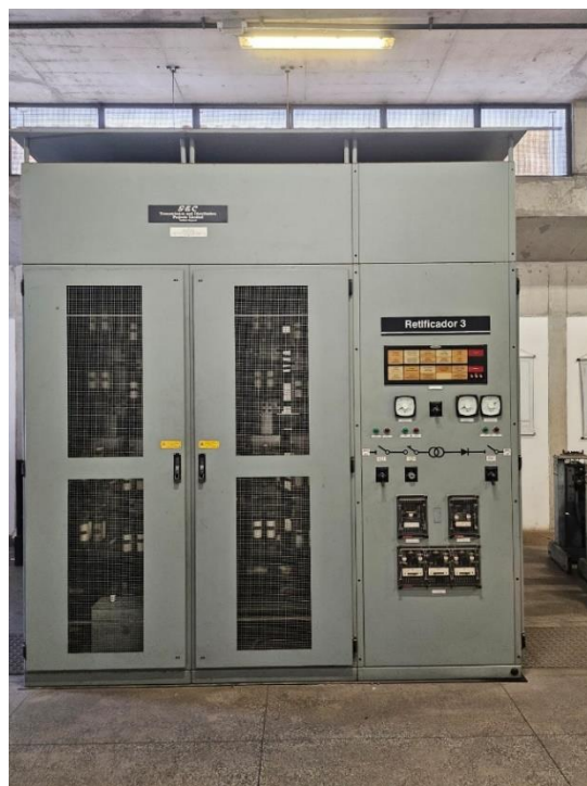
Foto 7-2: Pannel do retificador 3
