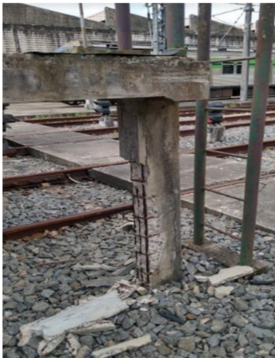
Foto 12-56: Coluna da Passarela de Pilotos, na Linha de Testes, com ferragens expostas e oxidadas
