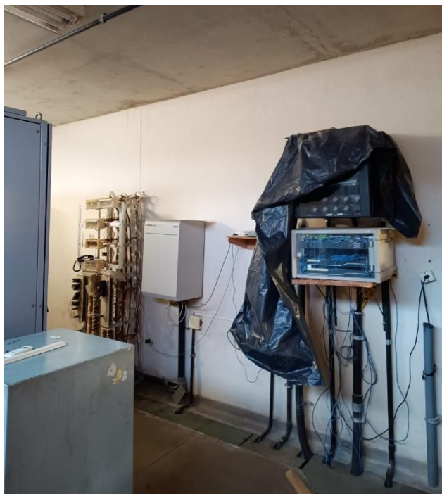
Foto 9-54: Equipamento coberto com plástico devido à ação de goteiras
