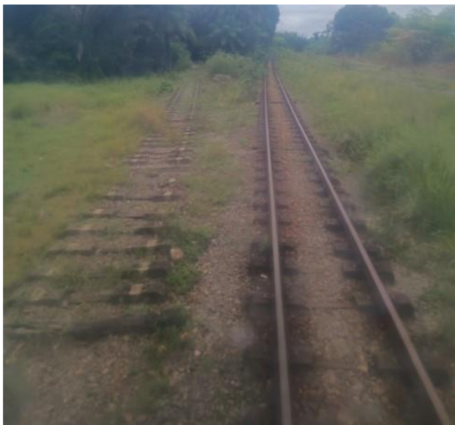
Foto 2-7: Trecho de duplicação da Linha Sul Diesel paralisado. Inicialmente este ramal seguiria para o Porto de Suape, hoje encontra-se com trilhos roubados e dormentes danificados
