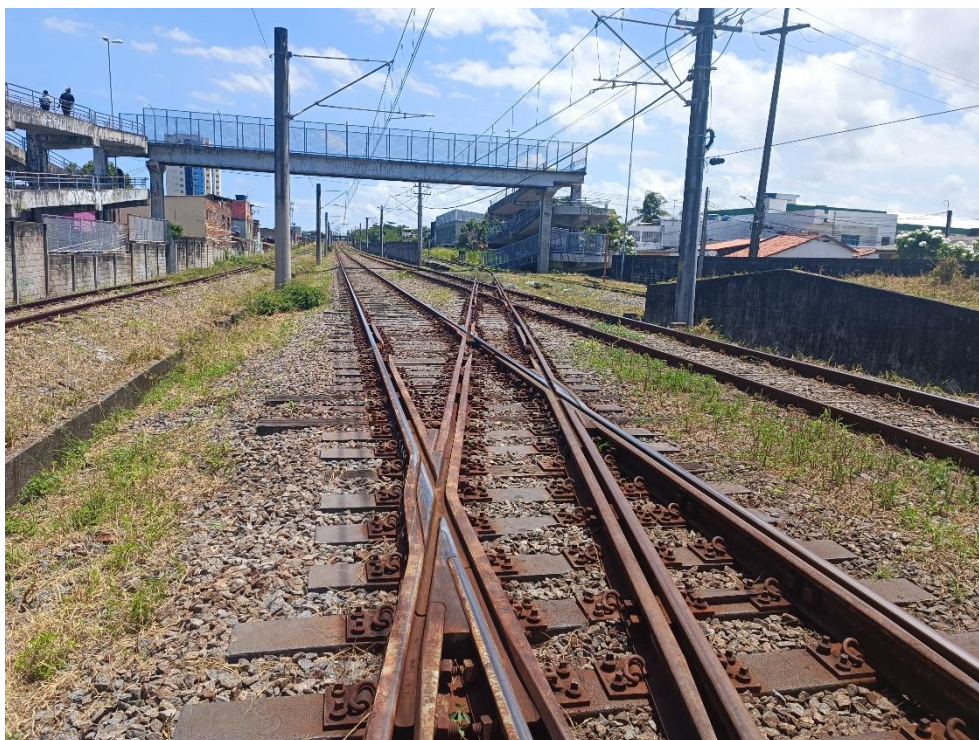
Foto 2-4: Vista da Linha Sul Elétrica – Região do ATV, onde a linha diesel de bitola métrica transpõe a linha elétrica de bitola larga.
