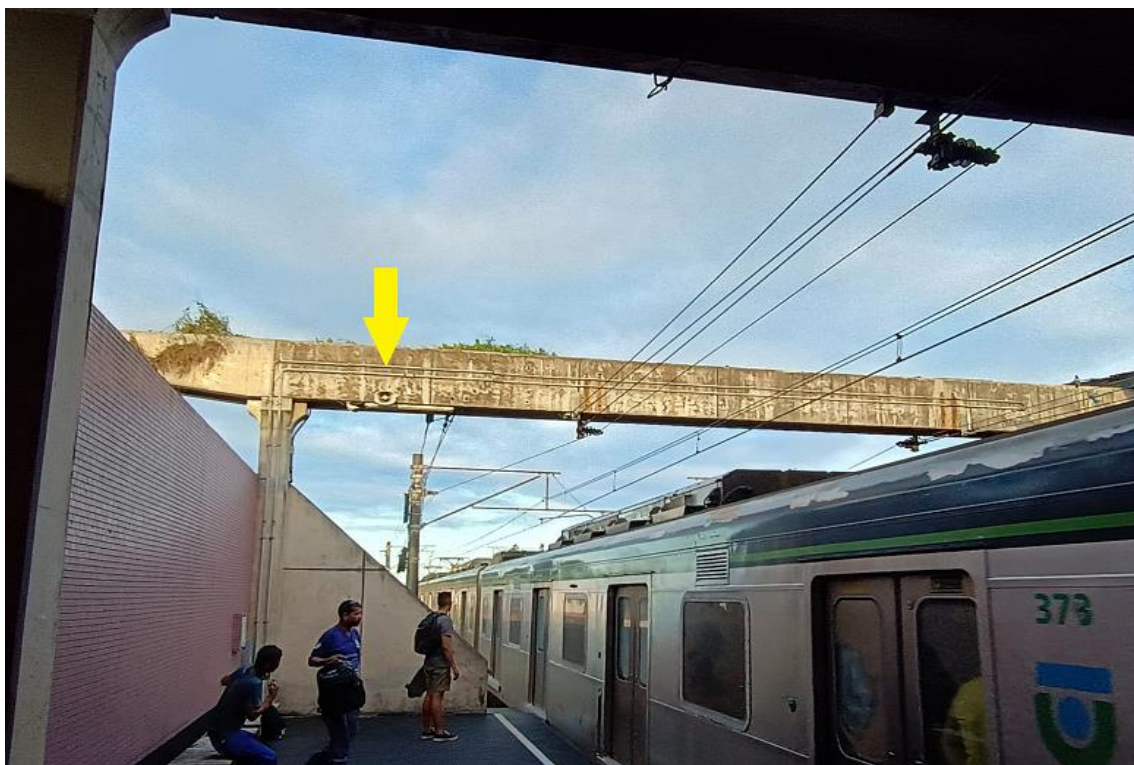
Foto 9-13: Corneta exposta à intempéries devido à queda de uma parte do telhado da estação Santa Luzia
