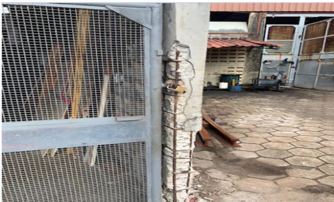
Foto 12-36: Ferragem Oxidada em Pilar no Anexo do Bloco 3 – Base de Manutenção
