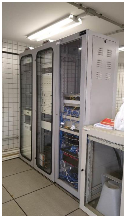
Foto 9-16: Rack de Sonorização: Estação Linha Sul Elétrica
