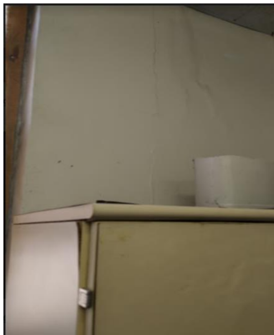
Foto 12-61: Sinais de infiltração e necessidade de recuperação estrutural
