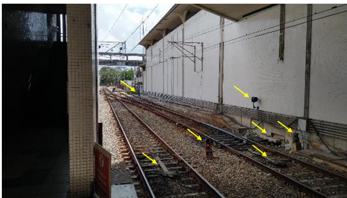
Foto 8-4: Prolongamentos de vias – Linha Centro – Estação Recife: Elementos do Sistema de Sinalização
