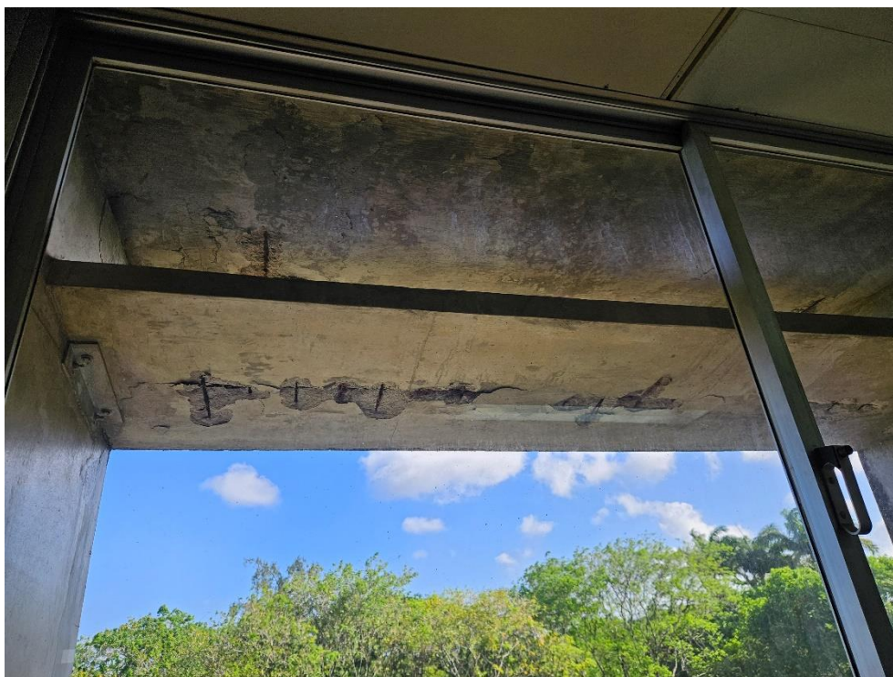
Foto 11-28: Prédio Administrativo – Ferragens expostas e infiltrações nos elementos de concreto da fachada
