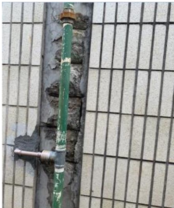
Foto 12-43: Coluna com ferragens expostas e oxidadas - lado sul do Bloco 4
