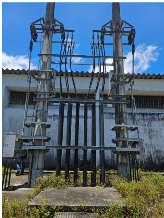
Foto 7-1: Estado atual dos pórticos com presença de mato nas estruturas
