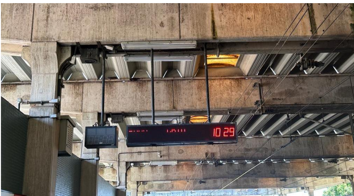
Foto 9-10: Painel de Informações operando com problemas – Plataforma da Estação Werneck
