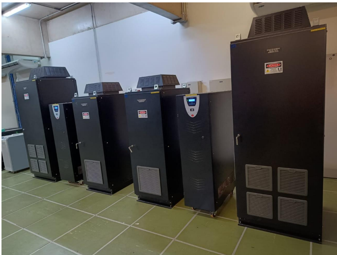
Foto 9-48: UPS e Banco de Baterias: Sala de Telecom – CCO
