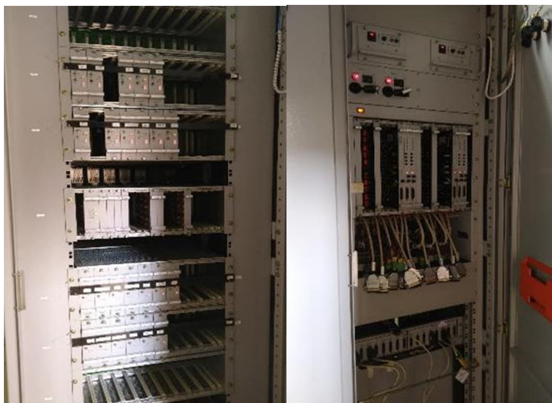
Foto 8-12: Linha Centro – Sala de Telecom da Estação Camaragibe: Bastidores Sinalização Alstom
