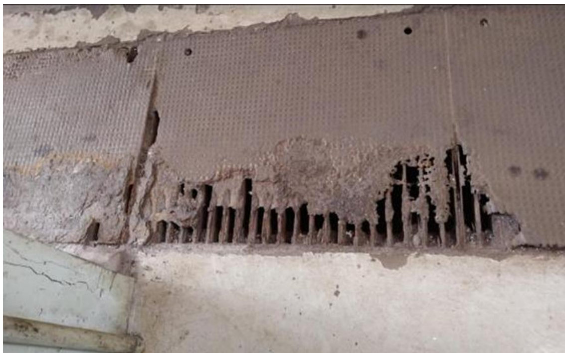
Foto 12-37: Tampa de Canaleta no Bloco 4 Oxidada
