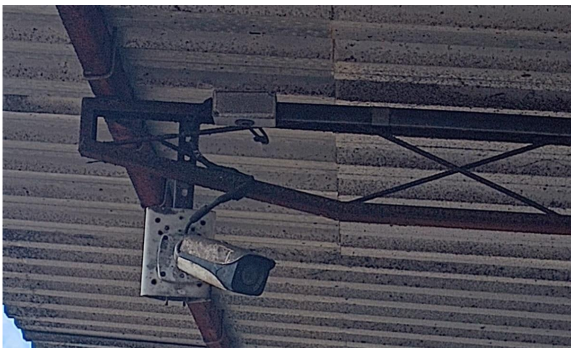
Foto 9-35: Câmera digital instalada de forma precária e sem conservação na estação Cabo – Linha Sul Diesel
