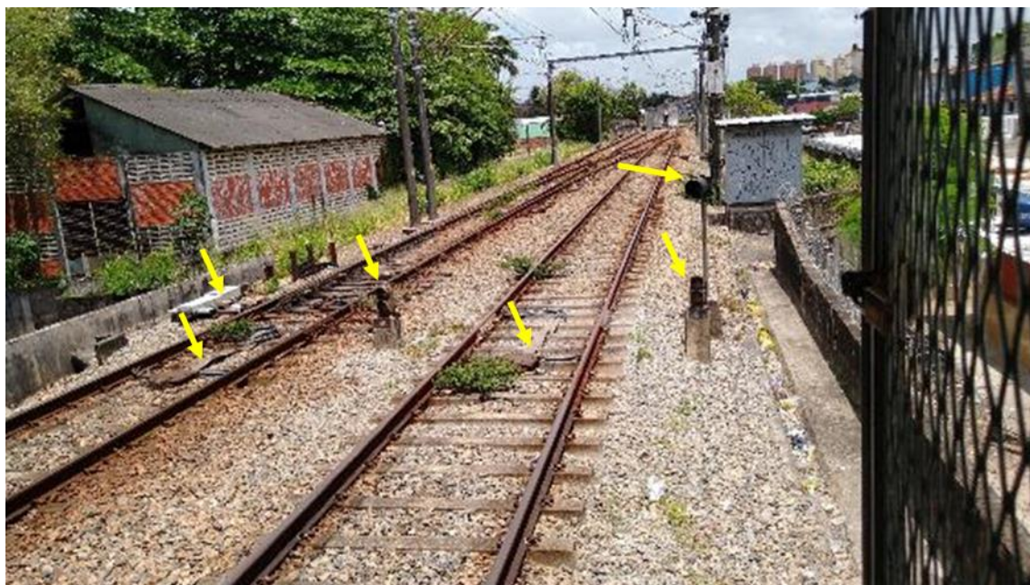
Foto 8-7: Linha Centro – Estação Werneck: Elementos de Sinalização de Via
