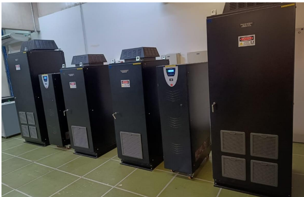
Foto 11-43: UPS instaladas na Sala de Telecom do CCO
