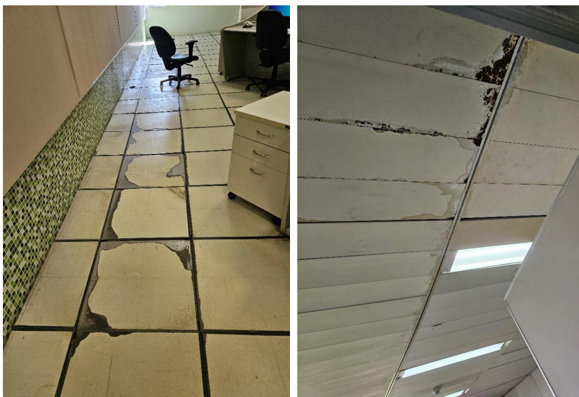
Foto 11-27: Pisos, Divisórias e Forros danificados
