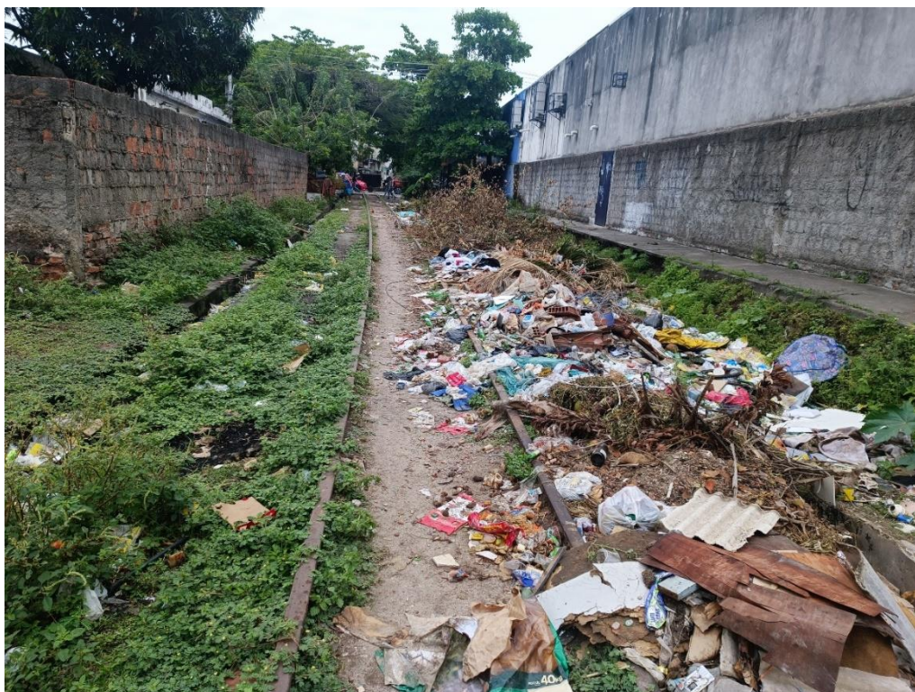
Foto 2-26: Contaminação de lastro, dormentes e acúmulo de lixo – Ramal Werneck-Linha Sul
