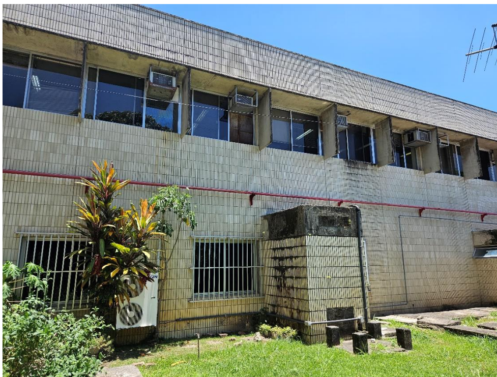
Foto 11-26: Prédio Administrativo – Revestimento cerâmico e de concreto necessitam de tratamento
