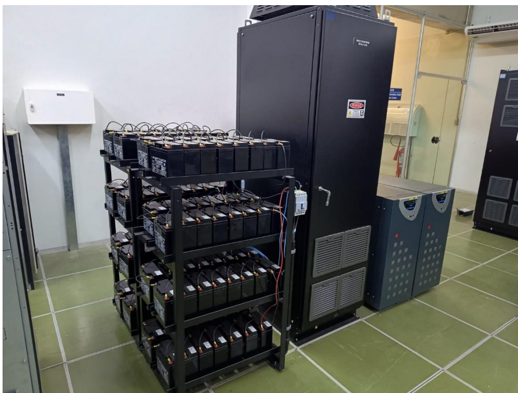
Foto 11-44: UPS + Banco de Baterias: Sala de Telecom do CCO
