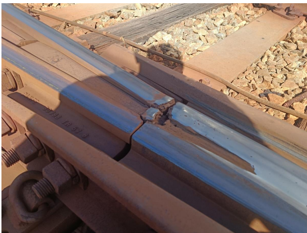
Foto 2-17: Aparelho de mudança de via danificado – Linha Centro
