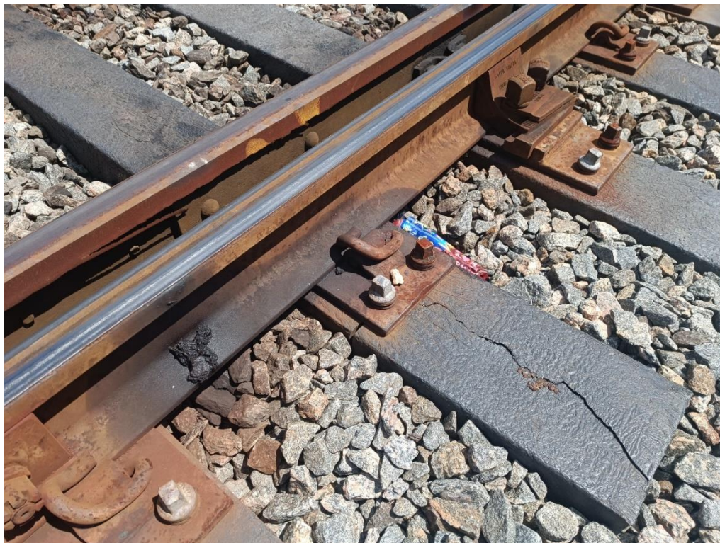
Foto 2-24: Dormente poliméricos de AMV comprometido (instalado em AMV's de dormente de madeira, favorecendo comportamento elástico diferenciado nos aparelhos) – Pátio Cajueiro Seco
