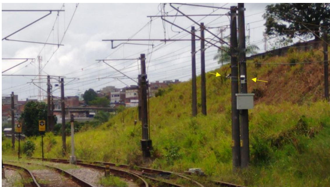
Foto 9-26: Câmeras instadas em poste de rede aérea – entrada do Pátio de Cavaleiro (CMC)
