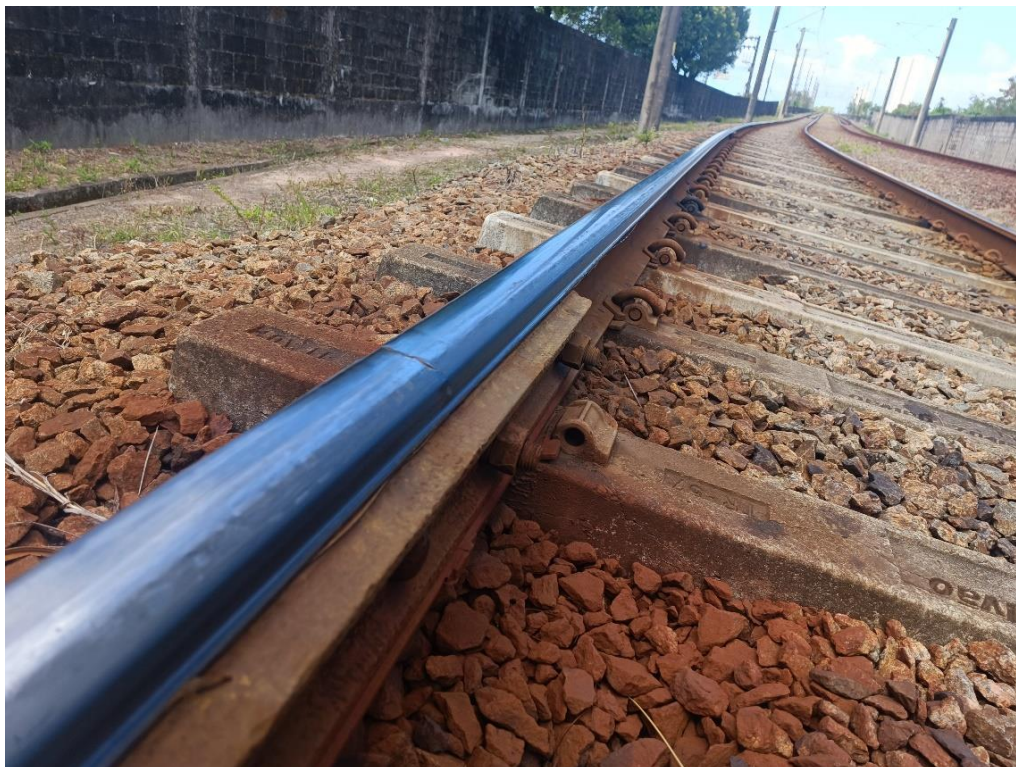
Foto 2-22: Curva unida por diversas juntas mecânicas (nota-se ao fundo), onde um trem descarrilhou em Novembro de 2020 e quebrou diversas soldas – Linha Sul Elétrica
