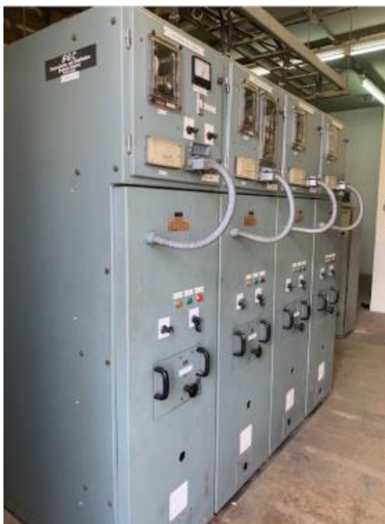
Foto 7-13: Painele de 3kV CC
