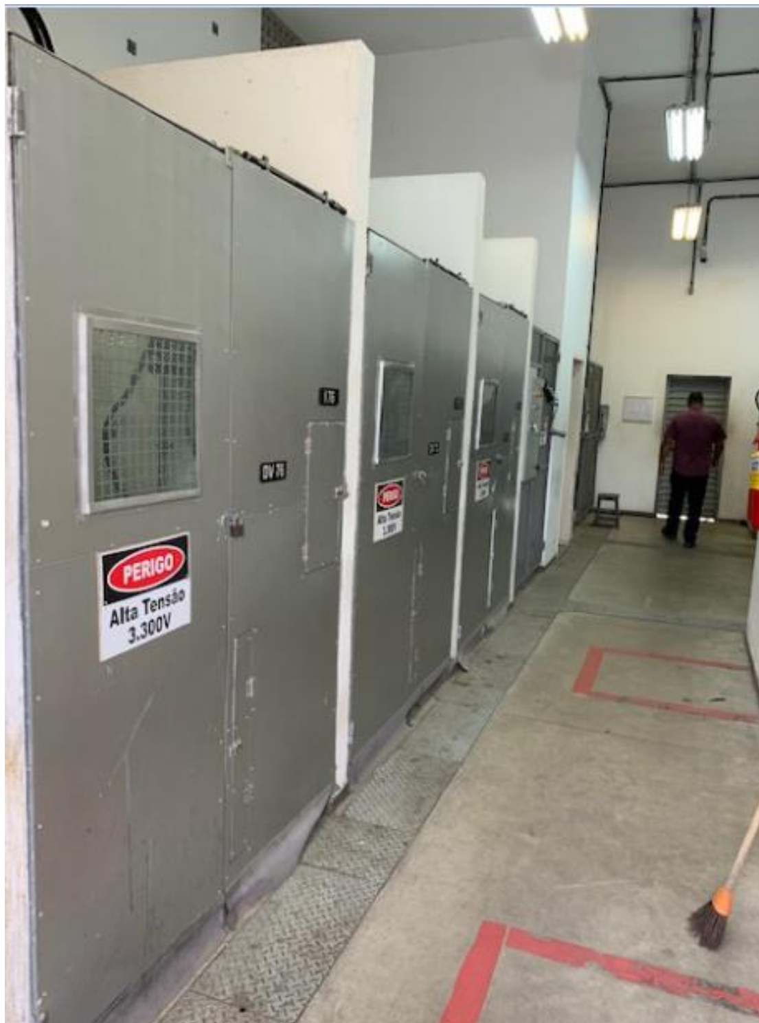
Foto 7-29: Celas dos disjuntores de via – 3 kV CC
