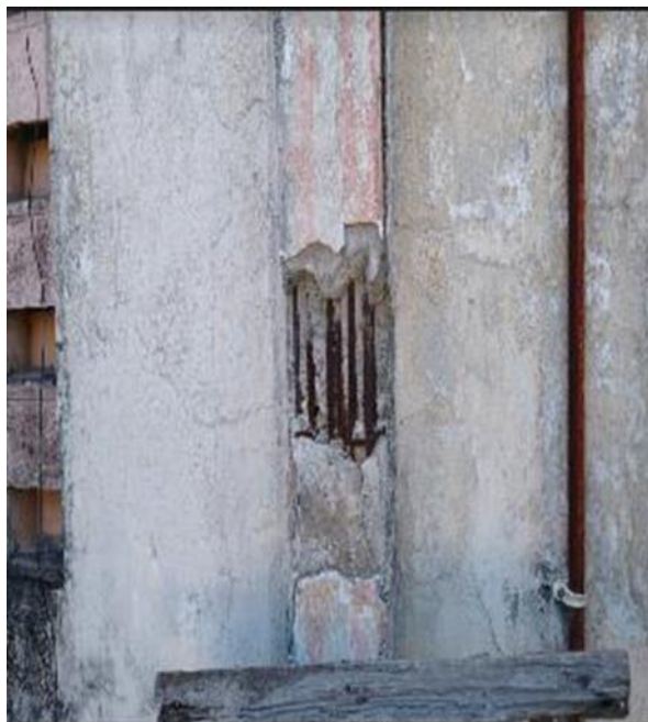
Foto 12-76: Detalhe da degradação da parede externa do galpão
