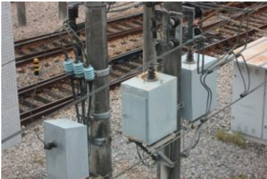
Foto 7-47: Caixas de VSU e pára raios com sinais de oxidação
