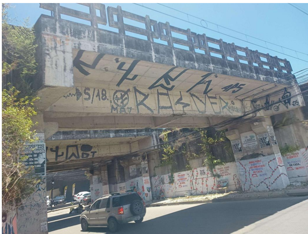
Foto 3-13: Ferragens expostas das vigas – Viaduto Ferroviário da Rua Joaquim Bandeira (ID 24, Tabela 3-2) – Linha Sul Elétrica
